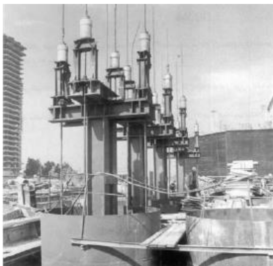
Rasm 13.27. Rostverni ko'tarish va tushirish uchun mo'ljalangan po'lat tayanch rigellari va gidravlik domkratlarning ko'rinishi (El-Moneeb ko'prigi)
