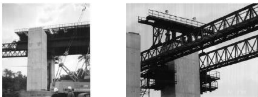
Rasm 12.27 Viaduk g‘arbiy qismini qurishda qo‘llanilgan harakatlanuvchi podmostlar (montaj fermalari)
