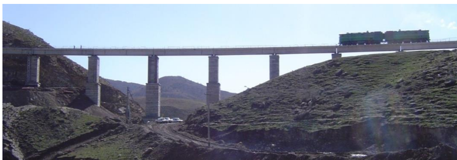
Rasm 1.3.a. To'sinli qirqilgan temirbeton ko'prik
