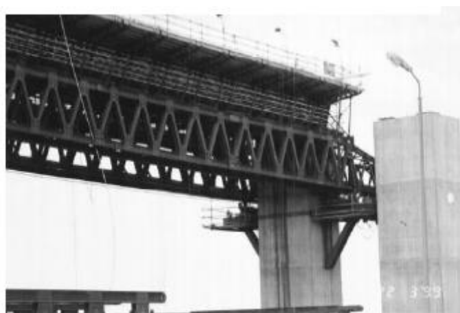
Rasm 12.23 Viaduk sharqiy qismini betonlash uchun harakatlanuvchi montaj fermasi
