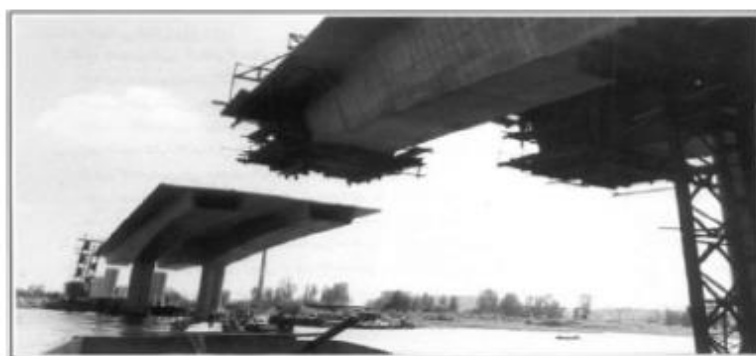
Rasm 12.32 Seksiyani betonlash (Rod El-Farag ko‘prigi)
