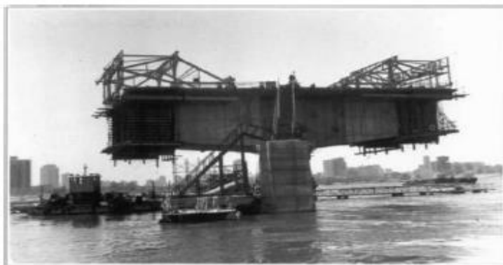
Rasm 12.31 Qo‘zg‘aluvchan podmostlarning oraliq tayanch ustida joylashishi
