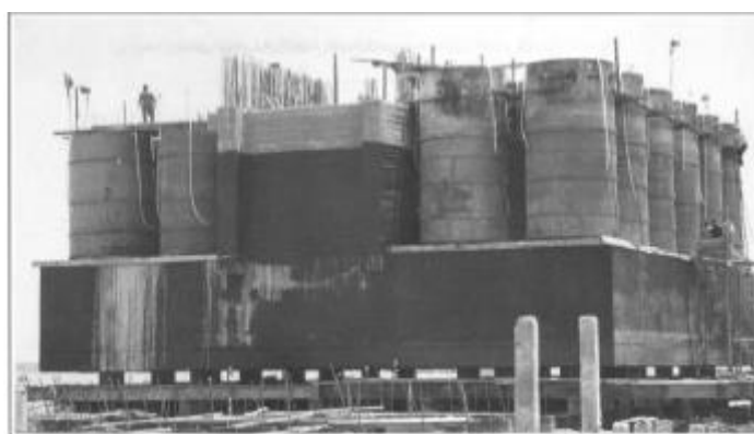
Rasm 13.26. Ishchi bo'lmasining osti va yon tomonlari betonlangandan keyingi ko'rinishi (El-Moneeb ko'prigi)
