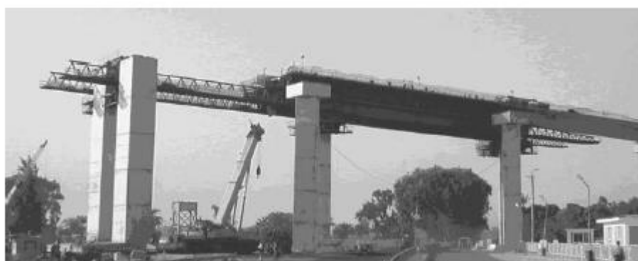
Rasm 12.26 Viaduk g‘arbiy qismining qurilishi (noyabr, 1999 y.)
