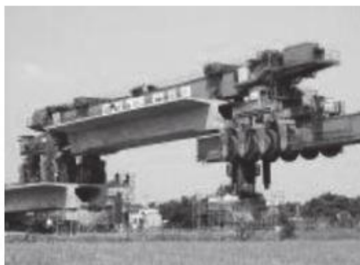
Rasm 12.55 To'la yig'ma oraliqlarni butunligicha qurish
