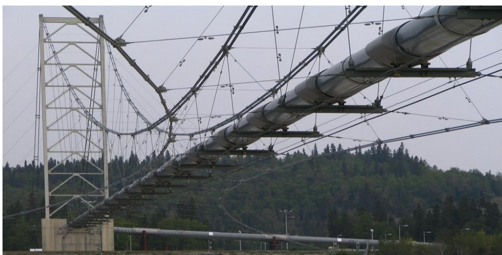
Rasm 1.13. Maxsus (quvur o‘tkazuvchi) ko‘prik
