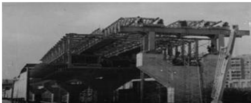
Rasm 12.8 Oraliq qurilmalarni ketma-ket betonlash bosqichi (6-oktyabr ko'prigi)
