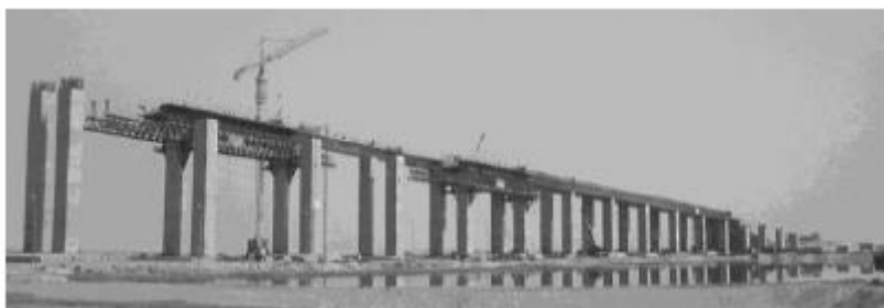
Rasm 12.22 Viaduk oraliq qurilmalari sharqiy qismining qurilishi (noyabr, 1999 y)
