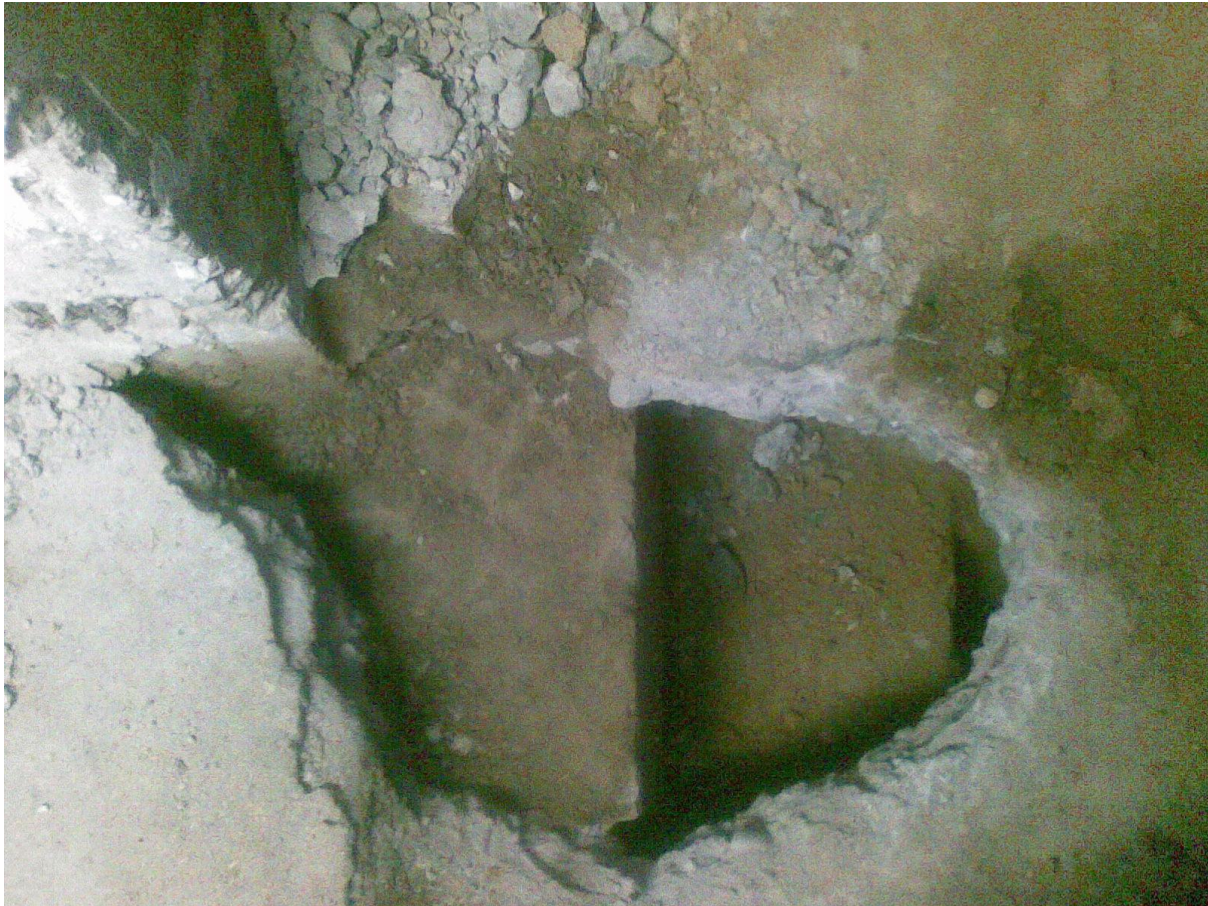
Рис 2.4 Контрольные вскрытия ленточных и отдельно-стоящих фундаментов стены
