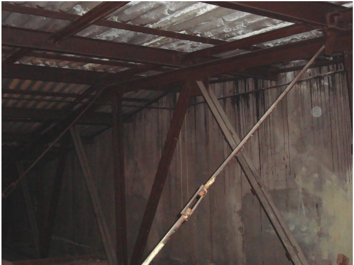
Рис 2.7 Металлические конструкции крыши
