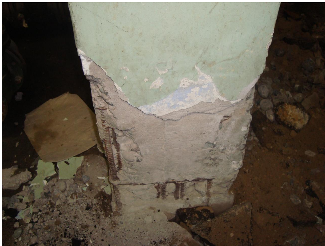
Рис 2.5 Вскрытия арматуры ж/б колонн подвала
