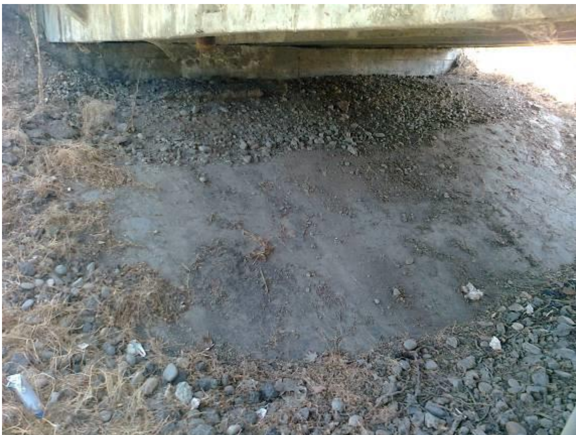
Фото 3. Общий вид устоя №3. Конуса насыпи укреплены монолитным бетоном.
