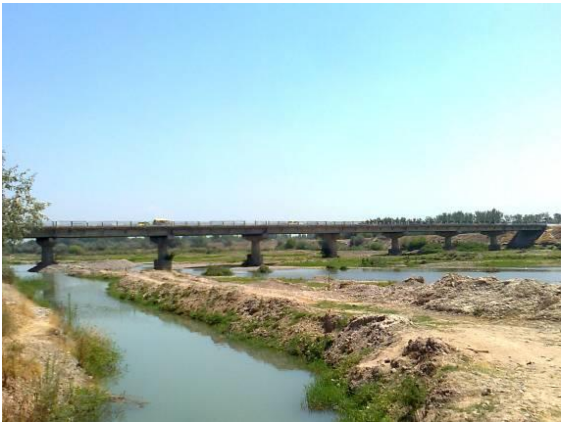
Фото 8. Общий вид моста
