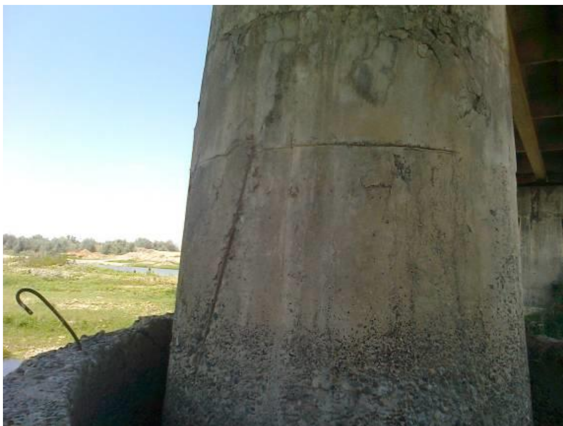
Фото 11. Вид промежуточной опоры №8. Наблюдаются сколы бетона, потеки и шелушение бетонной поверхности ригеля.
