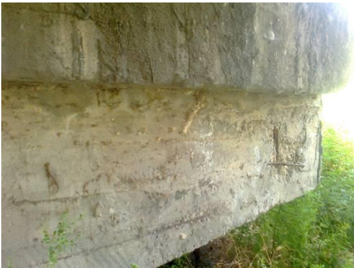
Фото 4. Вид промежуточной опоры №2. Наблюдаются сколы бетона, потеки и шелушение бетонной поверхности ригеля.
