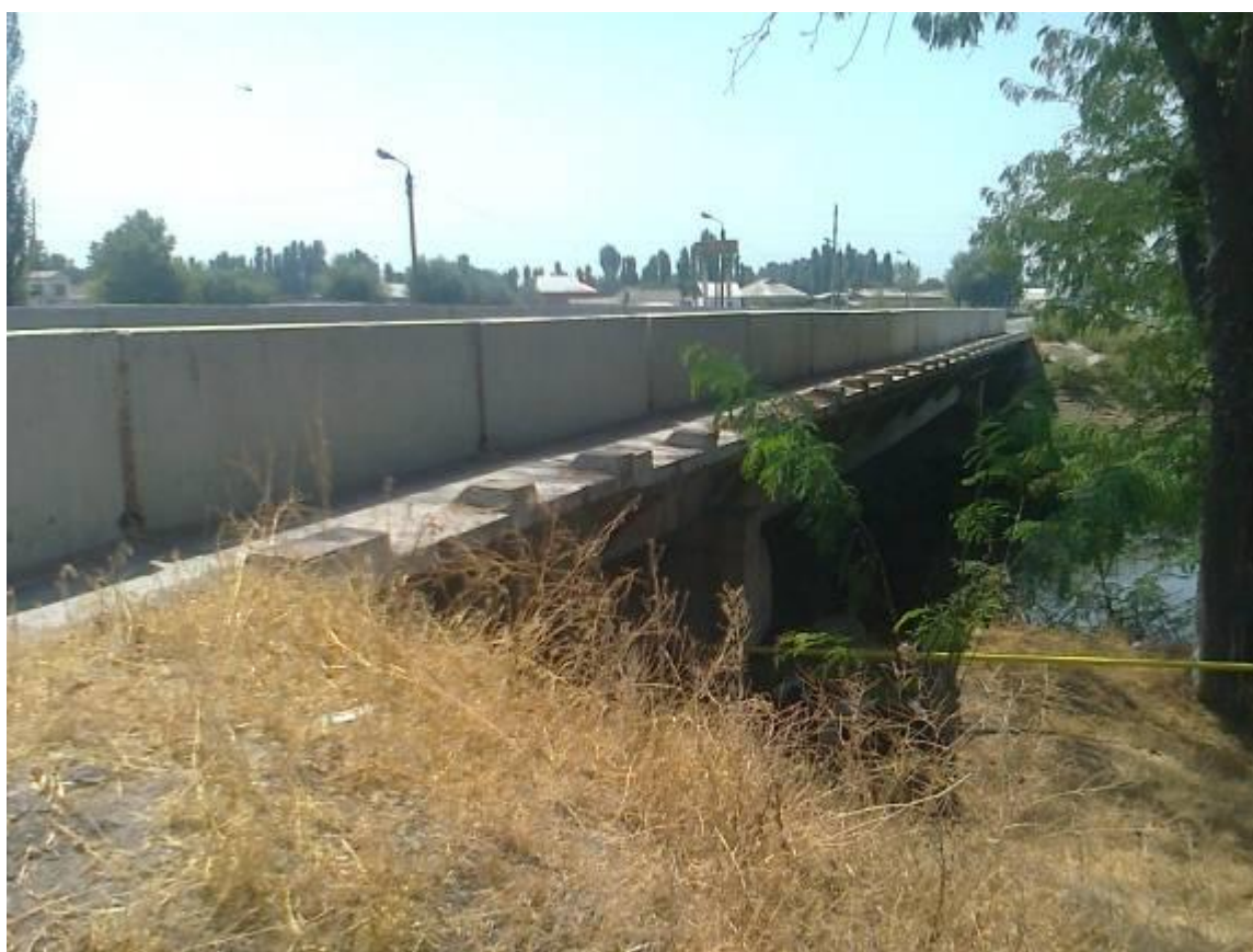
Фото 1. Общий вид моста
