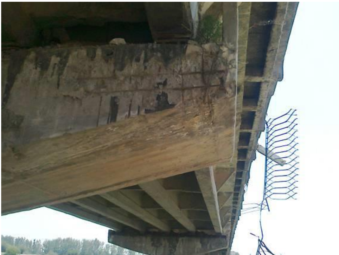
Фото 11. Вид промежуточной опоры №8. Наблюдаются сколы бетона, потеки и шелушение бетонной поверхности ригеля.
