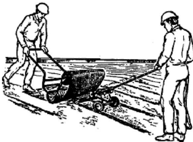
1.2-rasm. Eritiladigan ruberoid asosida tomni gidroizolyatsiyalash.
