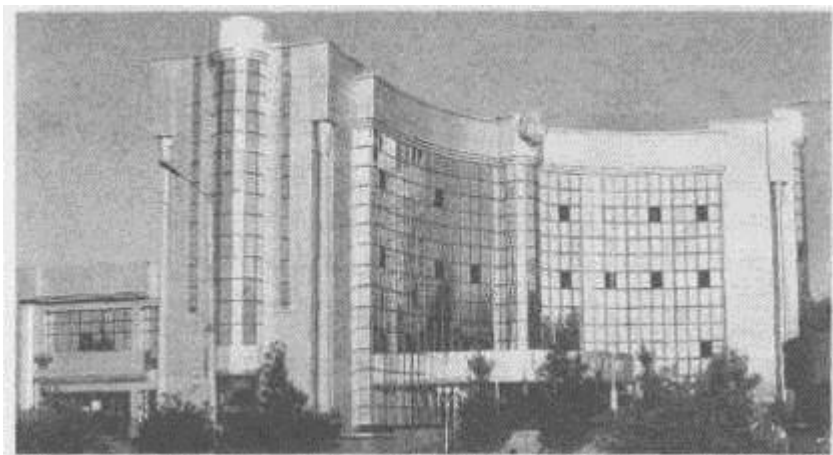
Bitxoro shahridagi zamonaviy uslubdu ishlanganyoy shaklidagi sanoat - qurilish banki binosining umumiy ko 'rinishi
