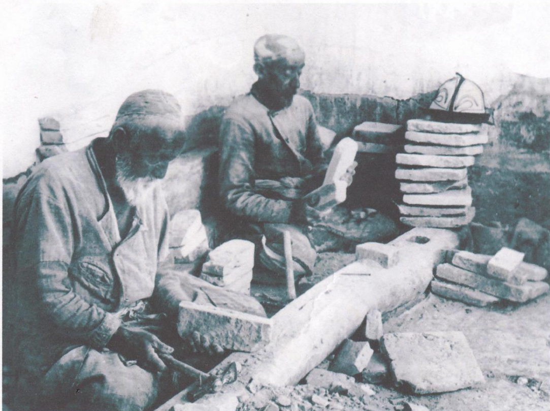
Уста Ширин Муродов Мағоки Аттoри масжиди таъмири жараёнида, 1932 йил. Уста Ширин Мурадov во время реставрации мечети Мағoки Аттoри, 1932 год. Usto – master Shirin Murodov during the restoration of Magoki Attori mosque, 1932.
