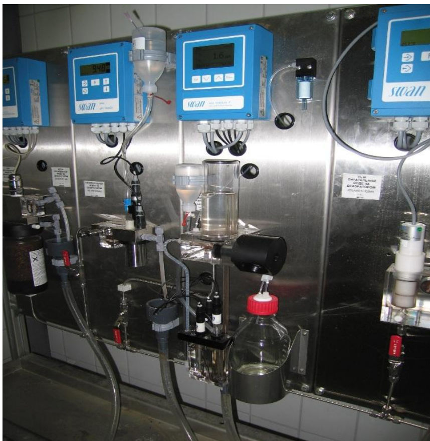
Рис.2.4. Возможный вариант размещения анализаторов на монтажной стойке.
