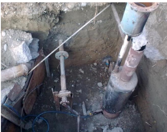
8 – rasm. Substratni qo'lda quyish va aralashtirishga hamda bioreaktor ichida substratni qizdirishga ixtisoslashtirilgan biogaz uskunasi.
