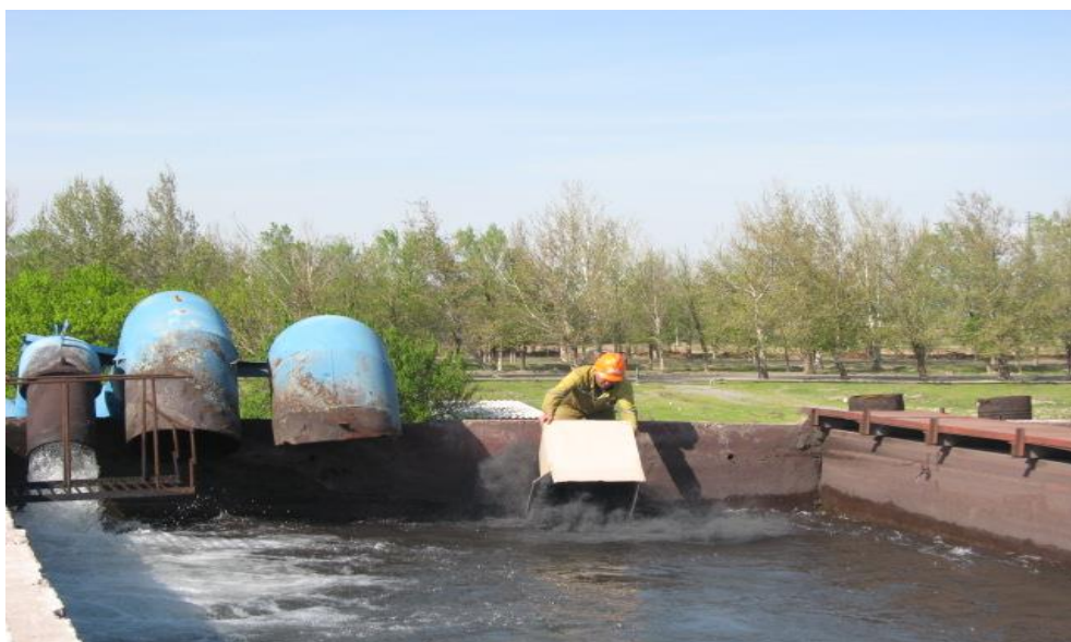
5-расм. Оқова сув таркибига ёғ ва моуларни шимиб олувчи сорбент қўшиш жараёни.
