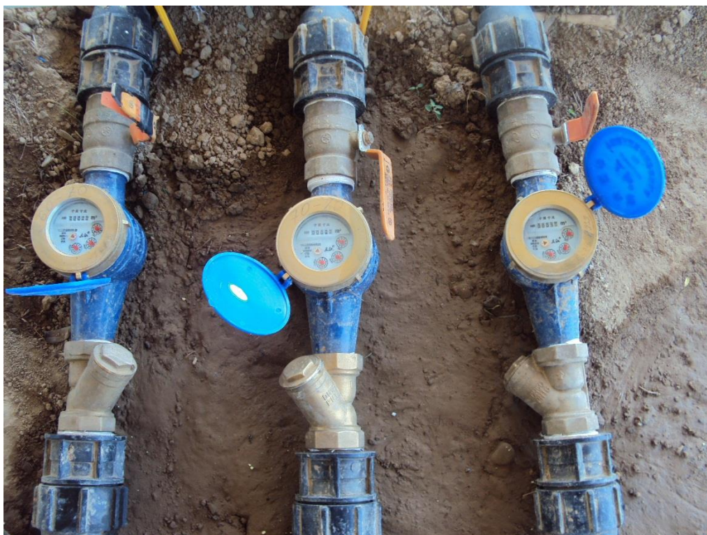
3.6 –расм. Томчилатиб суғориш тизимида сув сарфини аниқлайдиган сув ўлчагичлар.
