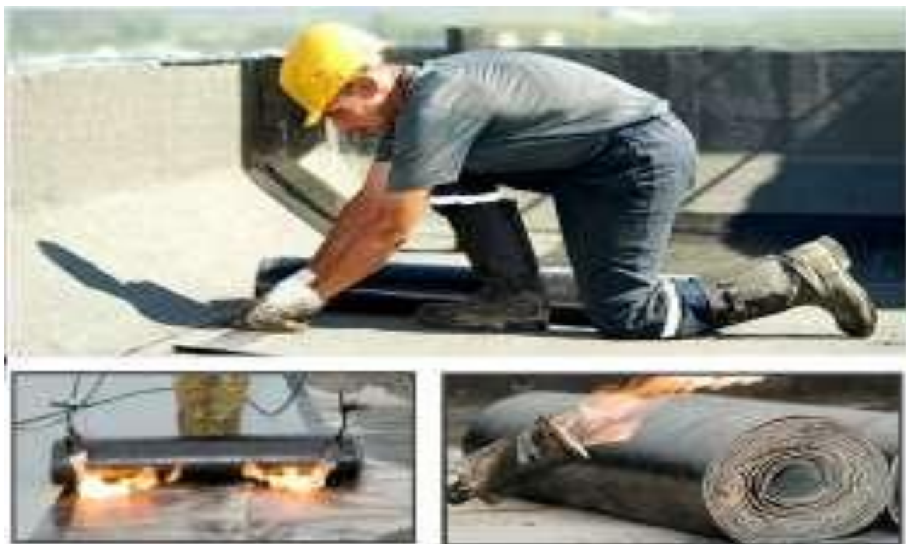
5-rasm. O'rama materiallarni egri joylarga to'shash jarayoni.
