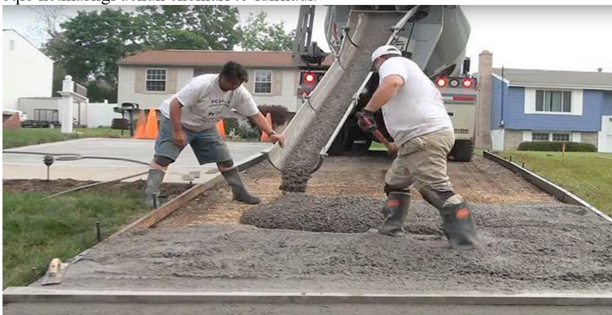
1-rasm. Beton quyish ishlari jarayoni.
