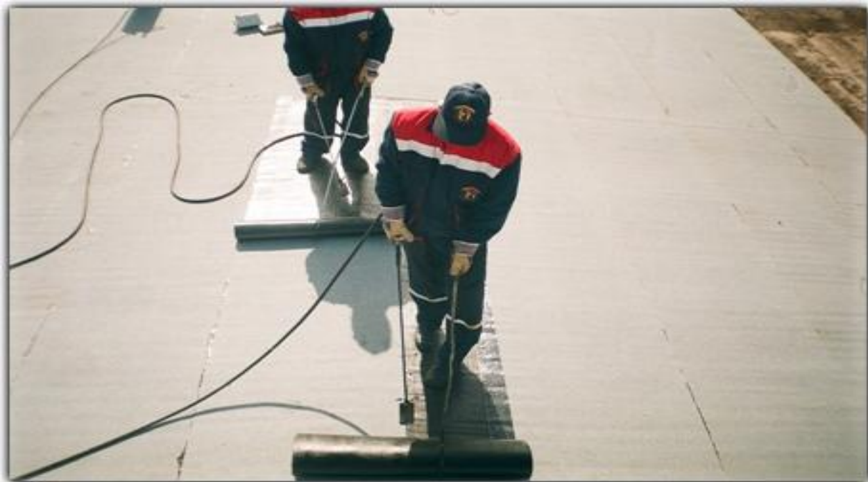
1-rasm. Eritib tushiriladigan tom yopuvchi va gidroizolyatsiya katlamni tushash jarayoni.
