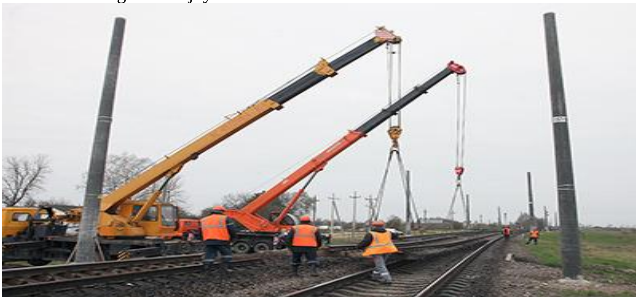
4-rasm. Temir yo'llarni elektrlashda montaj ishlari
