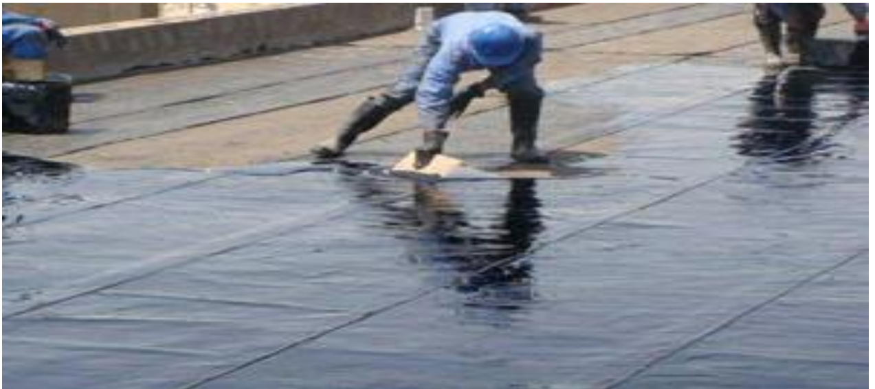
2-rasm. Mastikali tomlar quyish jarayoni.
