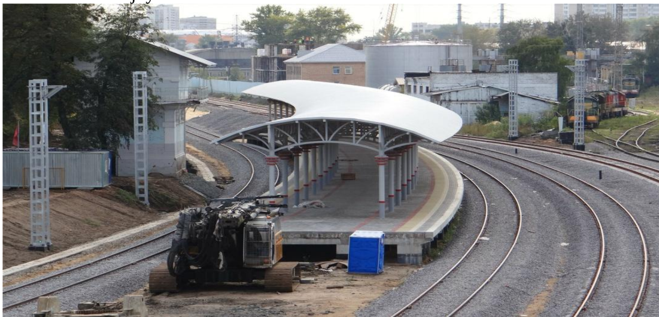
6-rasm. Yig'ma temirbeton elementlaridan tashkil topgan baland platforma
