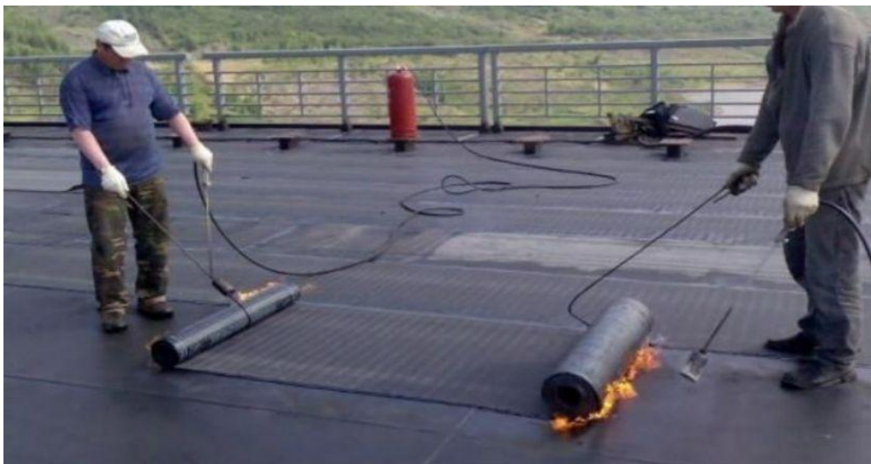
7-rasm. O'ram materiallar yordamida tom qoplamalarini qoplash ishlari jarayoni.
