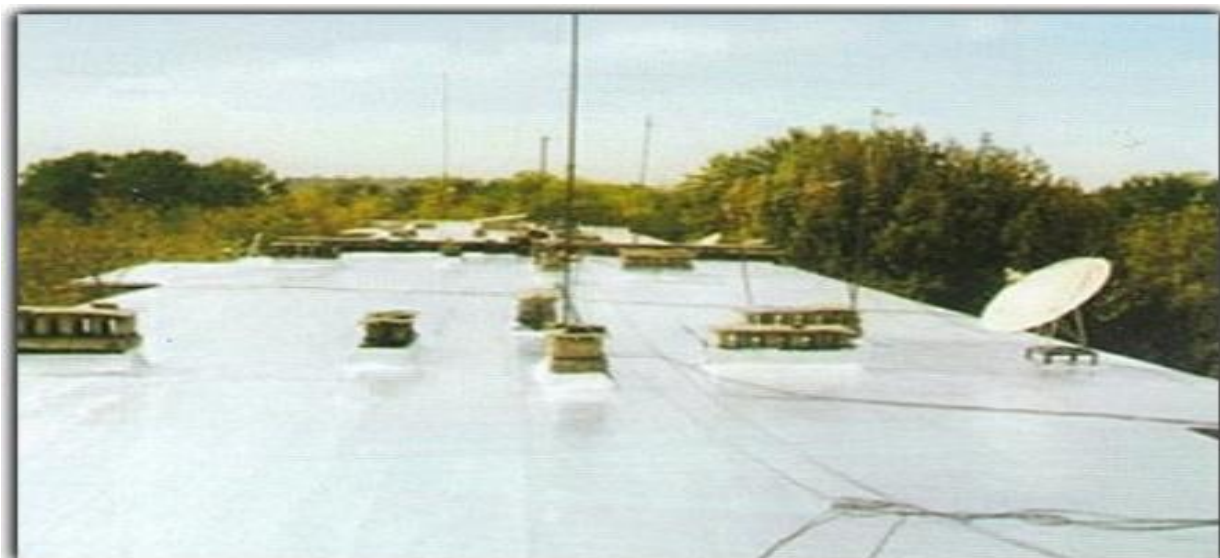
2-rasm. Eritib gidroizolyatsiya katlamli tom.
