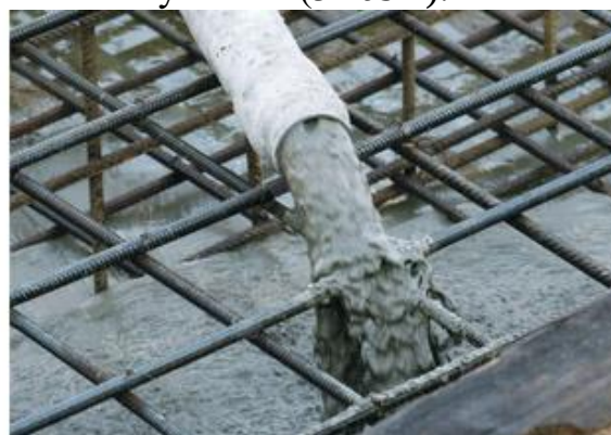
2-rasm. Beton qorishmasini nasos yordamida qabul qilish jarayoni
