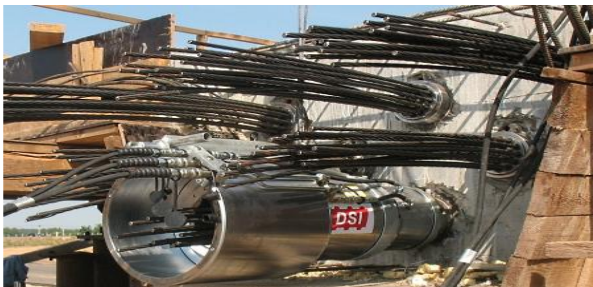
3-rasm. Armaturani oldindan zo'riqtirish jarayoni.
