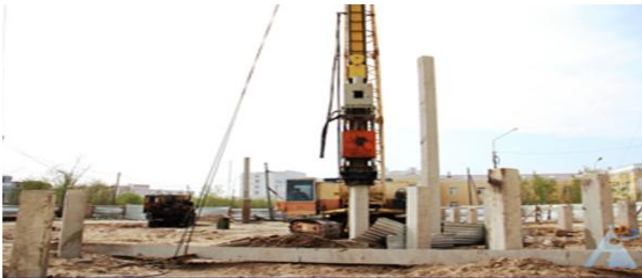
1-rasm. Svayani zarbli uslub bilan qoqish jarayoni.
