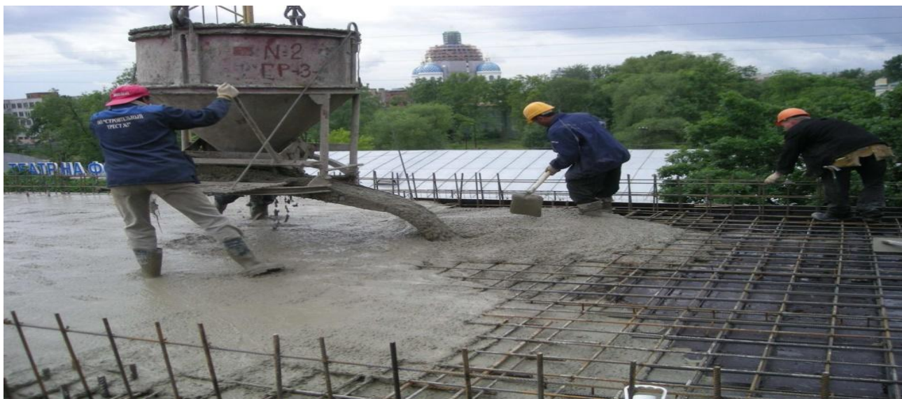
2-rasm. Beton qorishmasini qabul qilish jarayoni.
