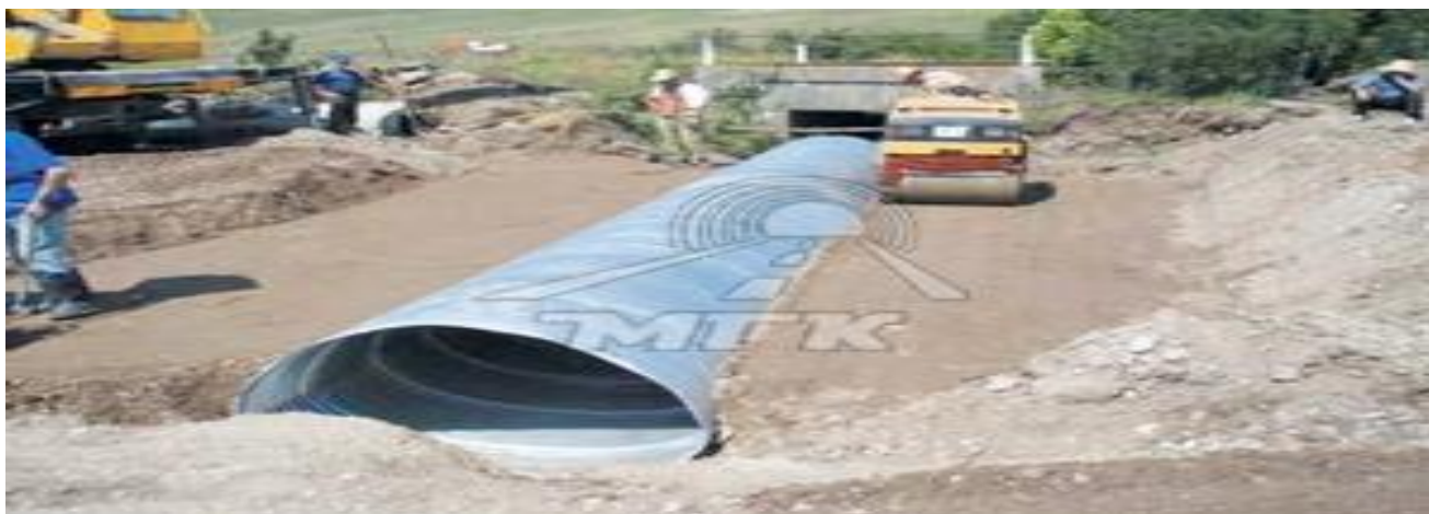
11-rasm. Gofrirlangan quvurni montaj jarayoni.
