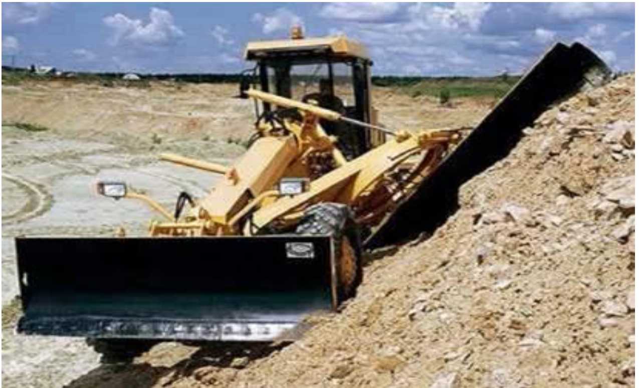
11-rasm. Avtogreyder yordamida ko'tarma qiyaligini tekislash jarayoni.
