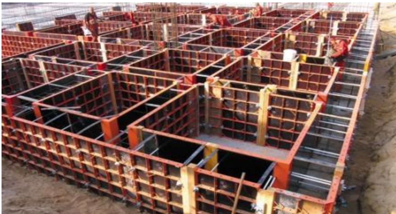
1-rasm. Panelli yig'ma-ko'chiriladigan opalubkalar montaj jarayoni.
