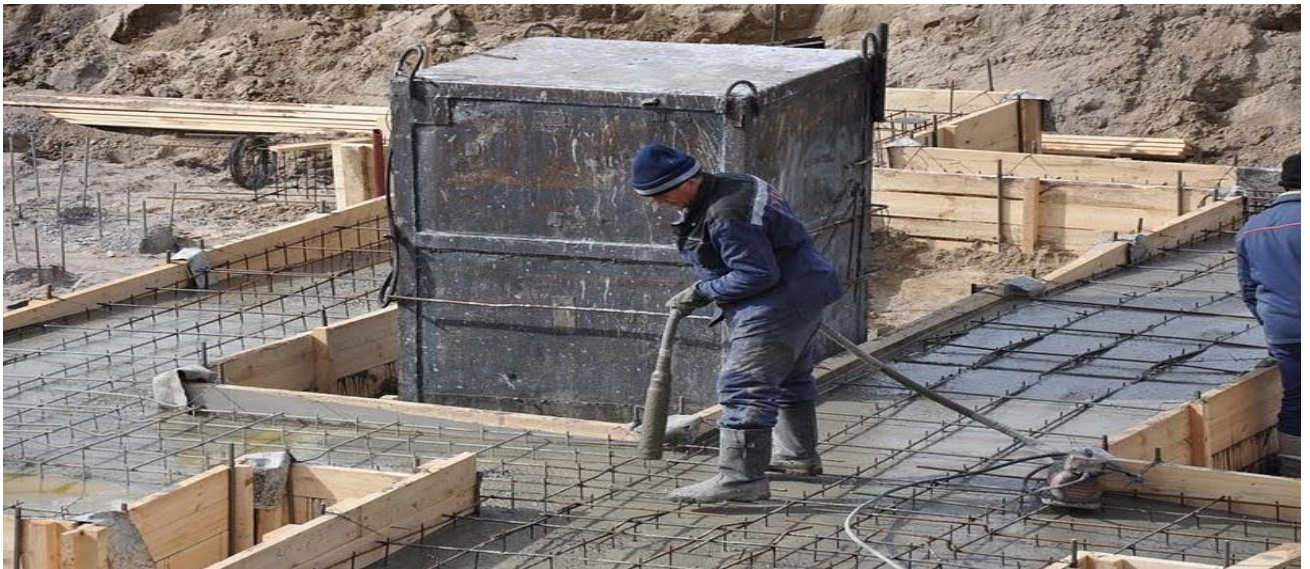
7-rasm. Beton ichida ishlovchi titratgichlar ishlash jarayoni.
