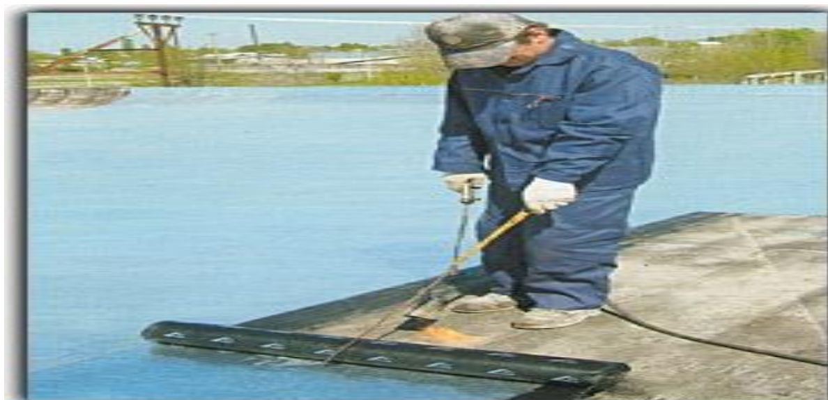
3-rasm. Eritib tushiriladigan tom yopuvchi va gidroizolyatsiya katlamni tushash jarayoni.
