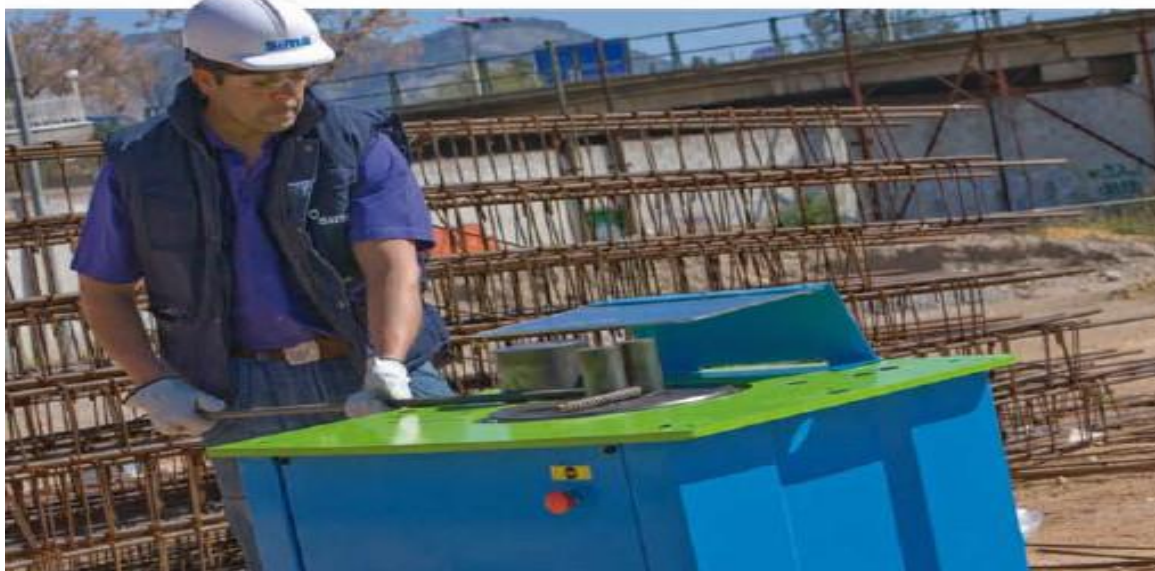
2-rasm. Sovuq holda armaturalarni egish jarayoni.
