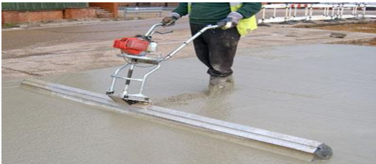
5-rasm. YUzani zichlovchi titratgichlar ishlash jarayoni.
