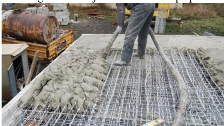
2-rasm. Beton qorishmasini nasos yordamida qabul qilish jarayoni
