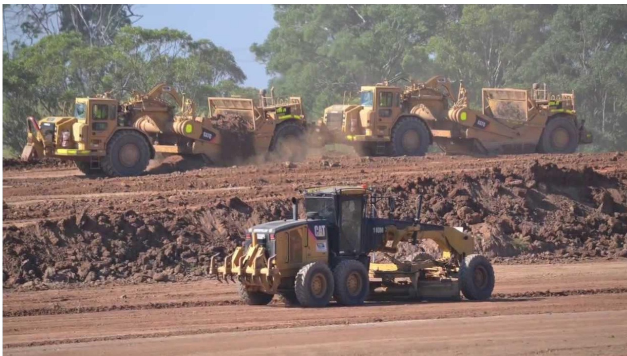
8.4-rasm. Yer polotnosini qurishda skreperlarning qo'llanilishi.
