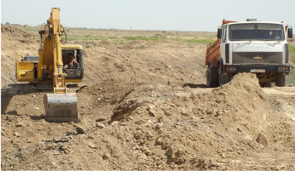
7.5- rasm. Gruntni rezervda ekskavator bilan qazib avtosamosvalga ortish
