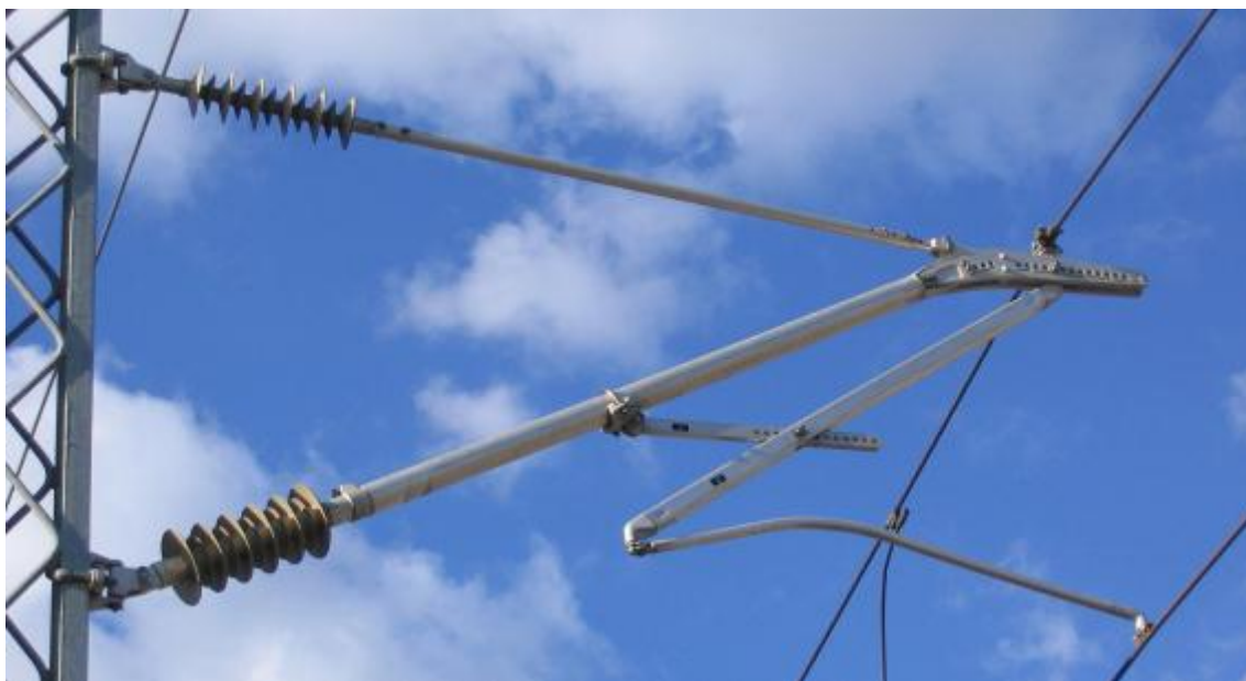
11.10-rasm. Alyumin qotishmalardan tayyorlangan fiksatorli konsol
