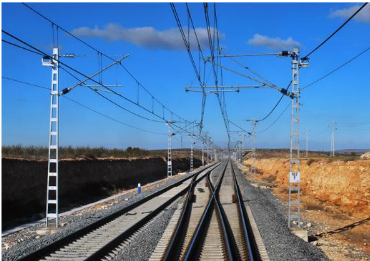
11.8-rasm. Kesishmaydigan kontakt simlarning havo strelkalari (doimiy tokdagi tezyurar kontakt osma misolida)
