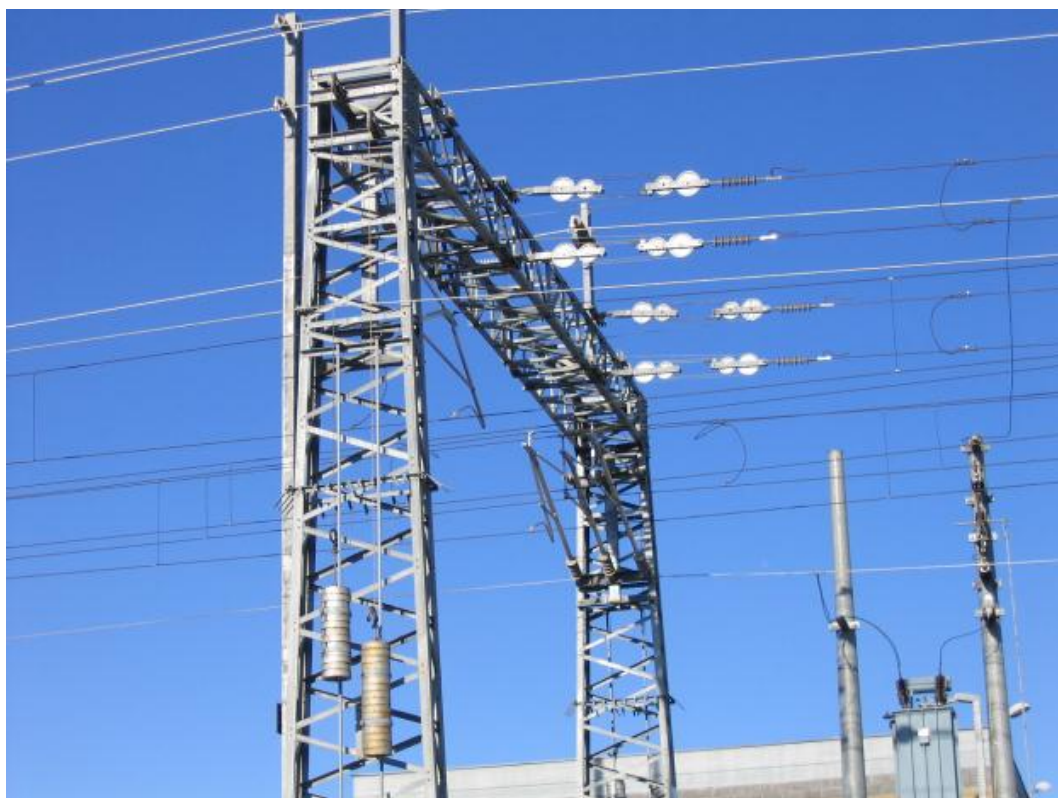
11.12-rasm. Stansiyada kontakt osmalarni ankerlash
