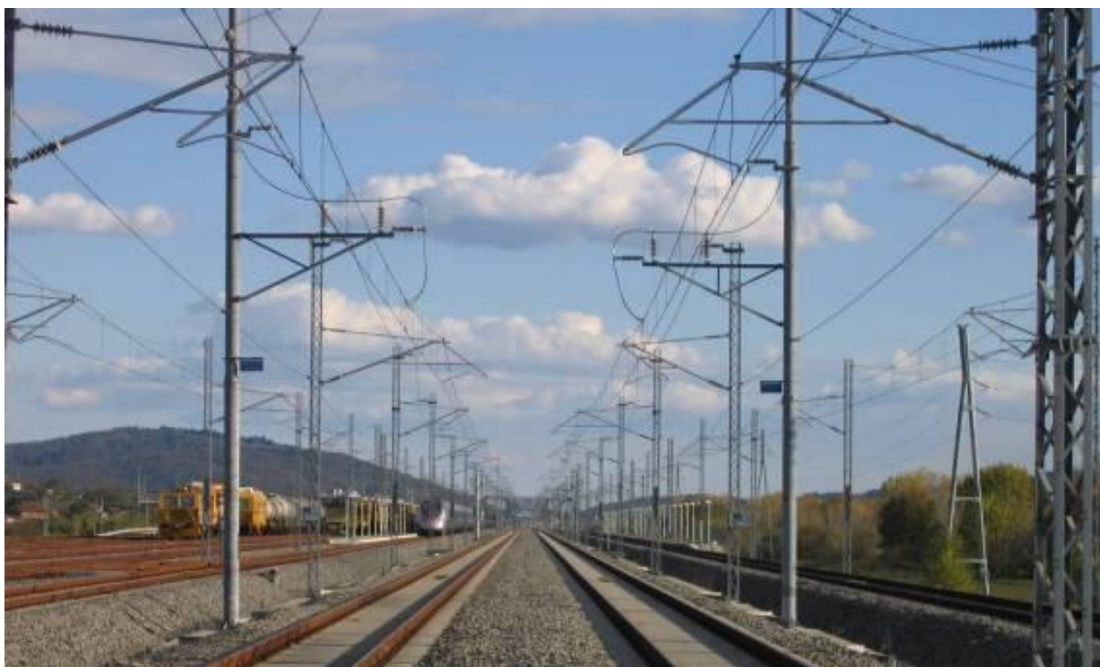
11.9-rasm. Rim–Neapol uchastkasida YuTM kontakt tarmog'i
