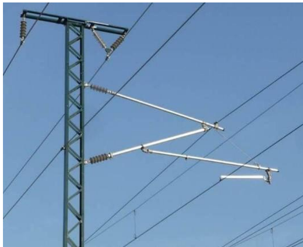
11.6-rasm. Ispaniyaning YuTMLaridagi alyumin qotishmali konsollar
