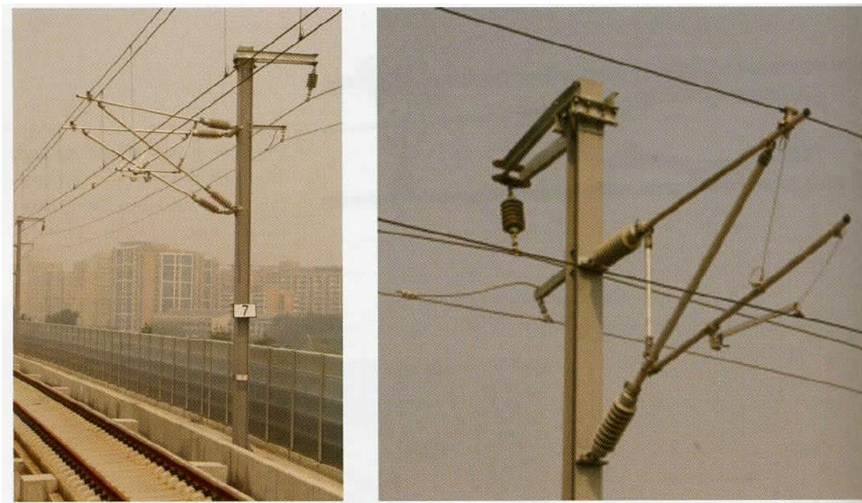
11.17-rasm. Pekin–Tyanszin liniyasida kontakt tarmoqning konsol tayanchi
