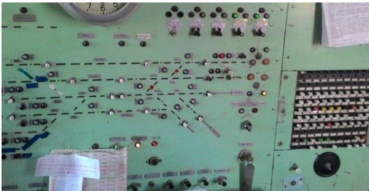
2-расм. Пулт-таблода тугмалар, узиб-улагичлар ва жезл-калит элементларининг жойлашуви
