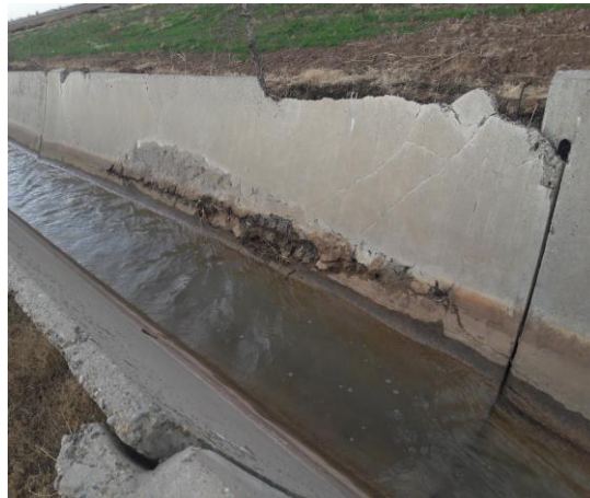
2-расм. Қашқадарё вилояти Қамашли тумани Қизилтепа ҚФЙда жойлашган нов каналнинг ҳозирги кундаги ишлаш ҳолати.
