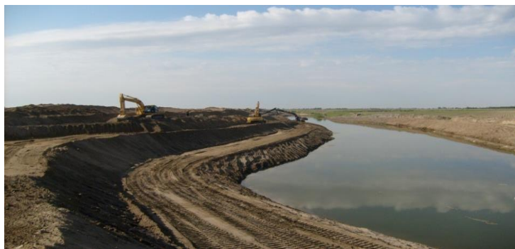
1-rasm. Zovurlarni tozalash va rekanstruksiya jarayoni.
