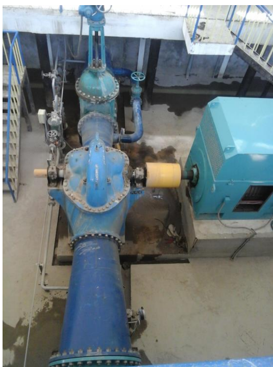
2.1.3-rasm. “Narpay” nasos stansiyasiga o’rnatilga “D” turdagi nasosning ko’rinishi
