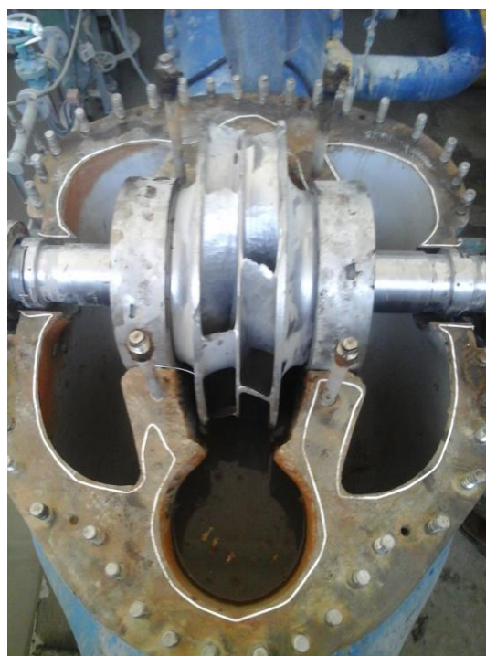
2.1.3-rasm. “Narpay” nasos stansiyasiga o’rnatilga “D” turdagi nasosning ko’rinishi
