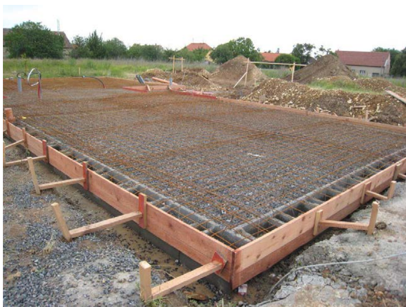
9.1-rasm. Zichlangan gruntда бетон поли.
