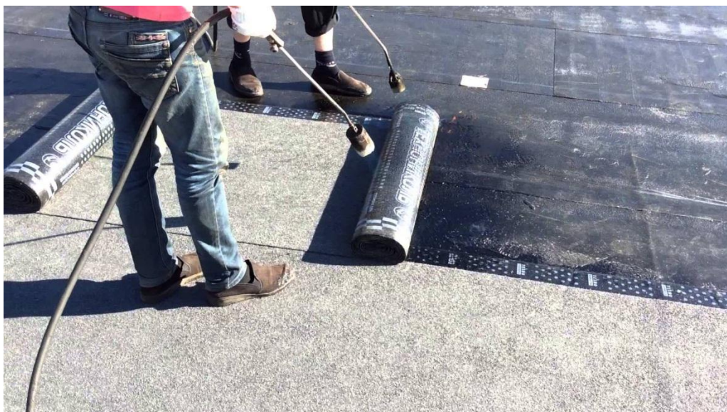
8.8-rasm. Bitum qatlami eritib yopishtiriladigan o‘rama materiallar.
