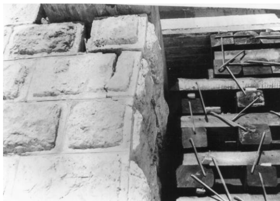
2.11-rasm. Tayanch kallaklari bo‘laklarini sinib tushib ketishiga misollar
