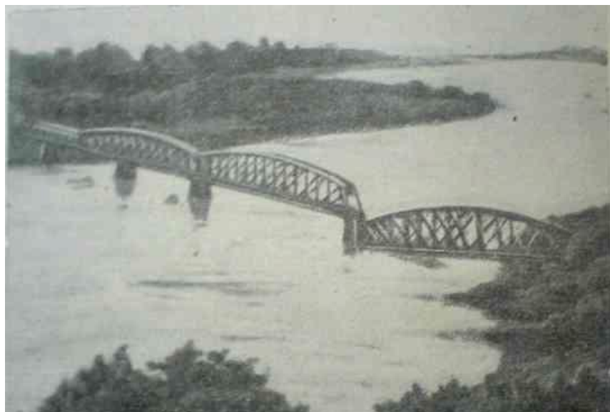
2.7-rasm. Kopper daryosi o 'stidagi ko 'prik oraliq qurilmasini qulashi (Alyaska, 1964 y.)
