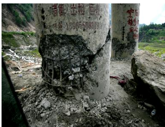
2.4-rasm. Venchuan viloyatidagi zilzila (Xitoy, 2008 y.) natijasida ko‘prik tayanchlari konstruksiyasini buzilishi va shikastlanishi
