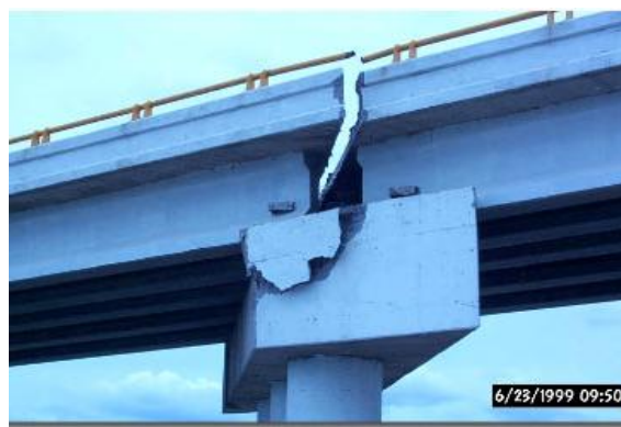
2.11-rasm. Tayanch kallaklari bo‘laklarini sinib tushib ketishiga misollar
