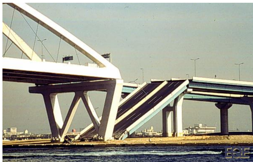
2.8-rasm. Kobadagi (Yaponiya, 1996 y.) zilzila vaqtida avtomobil yo'llari ko'prigining oraliq qurilmalarini qulashi
