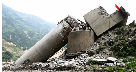
2.4-rasm. Venchuan viloyatidagi zilzila (Xitoy, 2008 y.) natijasida ko‘prik tayanchlari konstruksiyasini buzilishi va shikastlanishi
