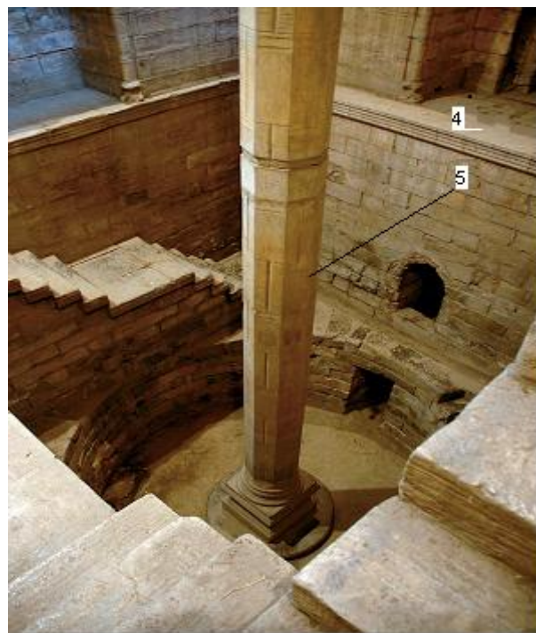
Rasm. Axmad Farg'oniyning Nil suvi sathini o'lchash qurilmasi. a- suv o'lchash inshotining qirqimi; b- suv o'lchash posti
