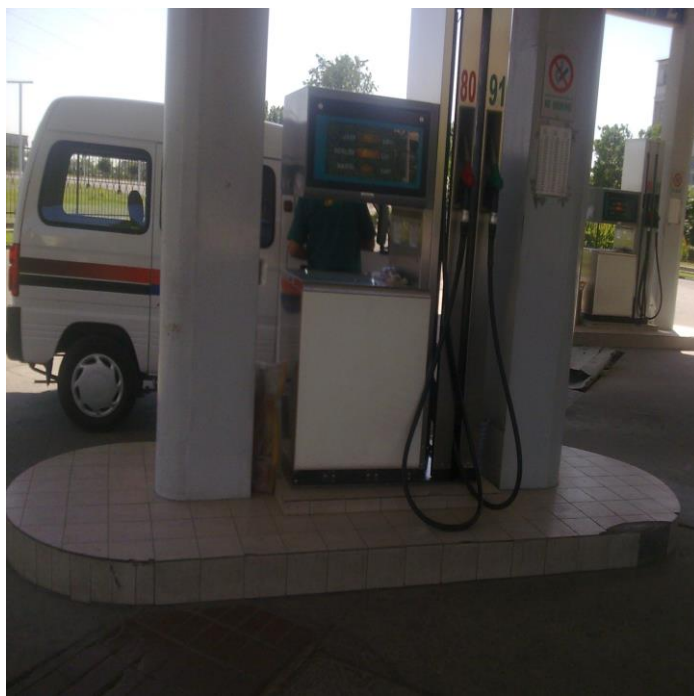
14.5-rasm. “UZMAL OIL” AYOQSH ning yoqilg’i rارقatish kolonkasi joylashgan orolchasi.
