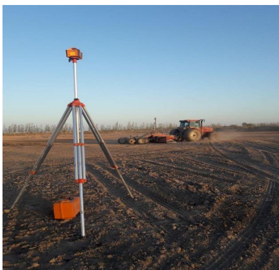
2.2.1-расм. Интенсив оналик тутзор барпо этиш учун ернинг лазерли текислашда тайёрлаш усули
