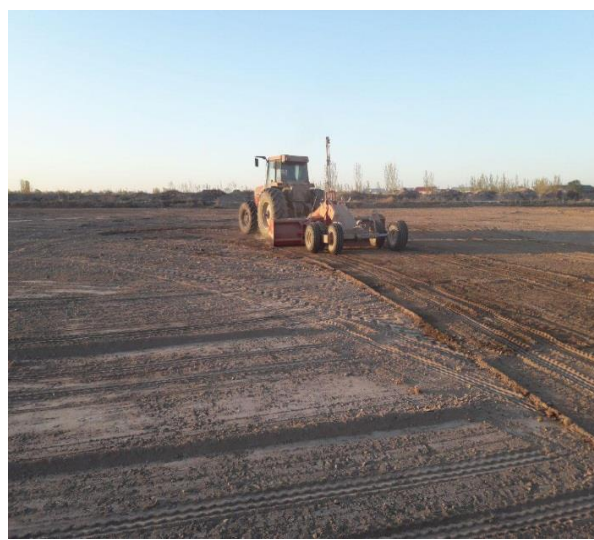
2.2.1-расм. Интенсив оналик тутзор барпо этиш учун ернинг лазерли текислашда тайёрлаш усули
