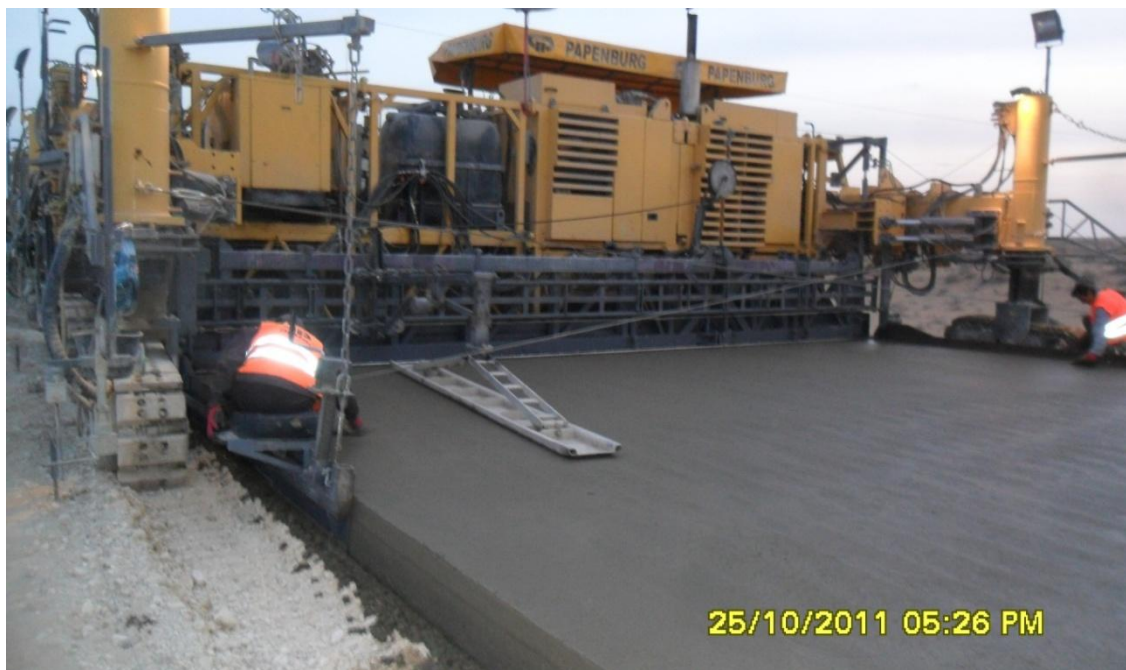
29-rasm. Yo'l to'shamasi qoplamasini qurish
