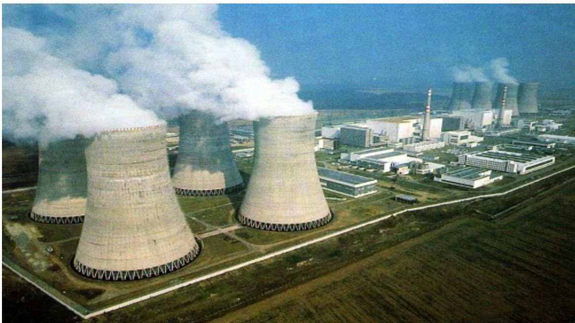
8-rasm. Yirik elektr ishlab chiqarish stansiyalari, Navoiy.
