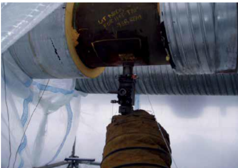
14.8 rasm. Izolatsiya. Energiyani tejash quvurlar juda yaxshi izolyatsiyalanishini talab qiladi. (Surat Shimoliy Slop Boroulik kichkina Vaska Vilyamsniki).
