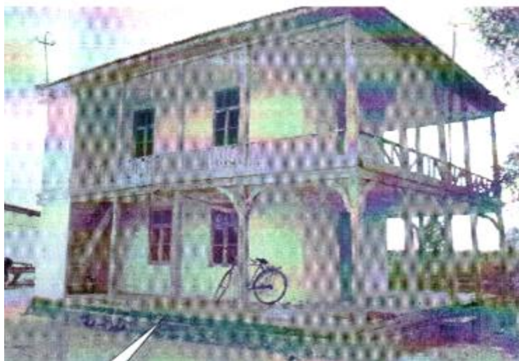
Расм 2.2. Икки қаватли айвон тизимли, режада тўғри тўртбурчак синч каркасли бино.
