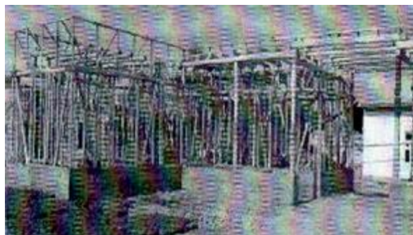
Расм 2.5.Том конструкцияси сифатида кесим юзалари думалоқ ва тўғрибурчакли ёғоч тўсинлар ишлатилган, кесим юзалари қурувчи усталарнинг йиллар давомида сақланиб келган “ҳисоблари”га асосан танланган бинолар.
