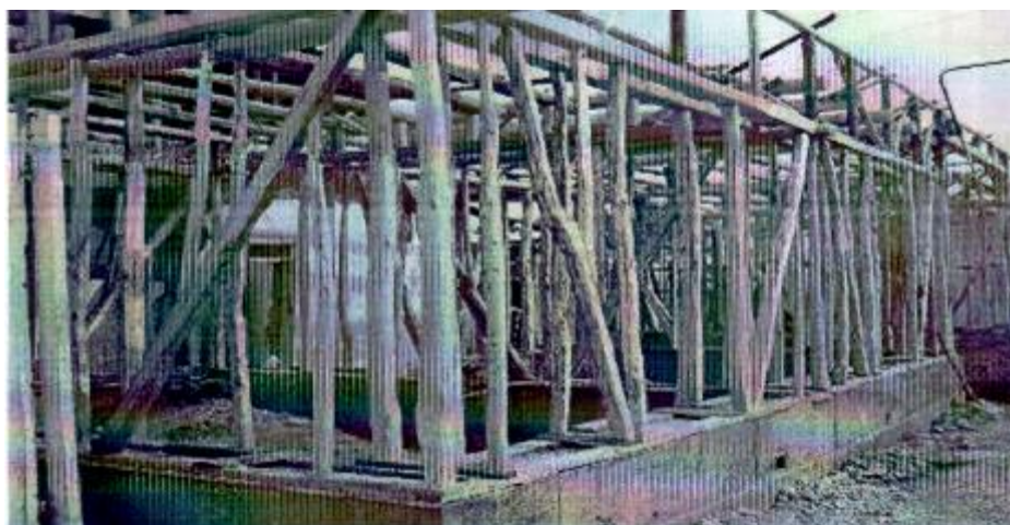
Расм 2.8. Синч каркасли биноларда қўлланилган айрим нуқсоли элементлар: пойдевор гидроизоляцияси; остки ва устки сарров кесим юзасини етарли эмаслиги; устунлар ва ховонлардаги буйлама нуқсонлари ва бошқа нуқсонлар;
