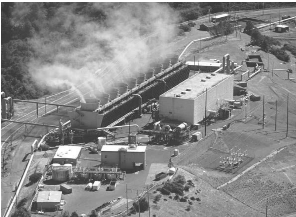
25-расм. Геотермал электр станция.
