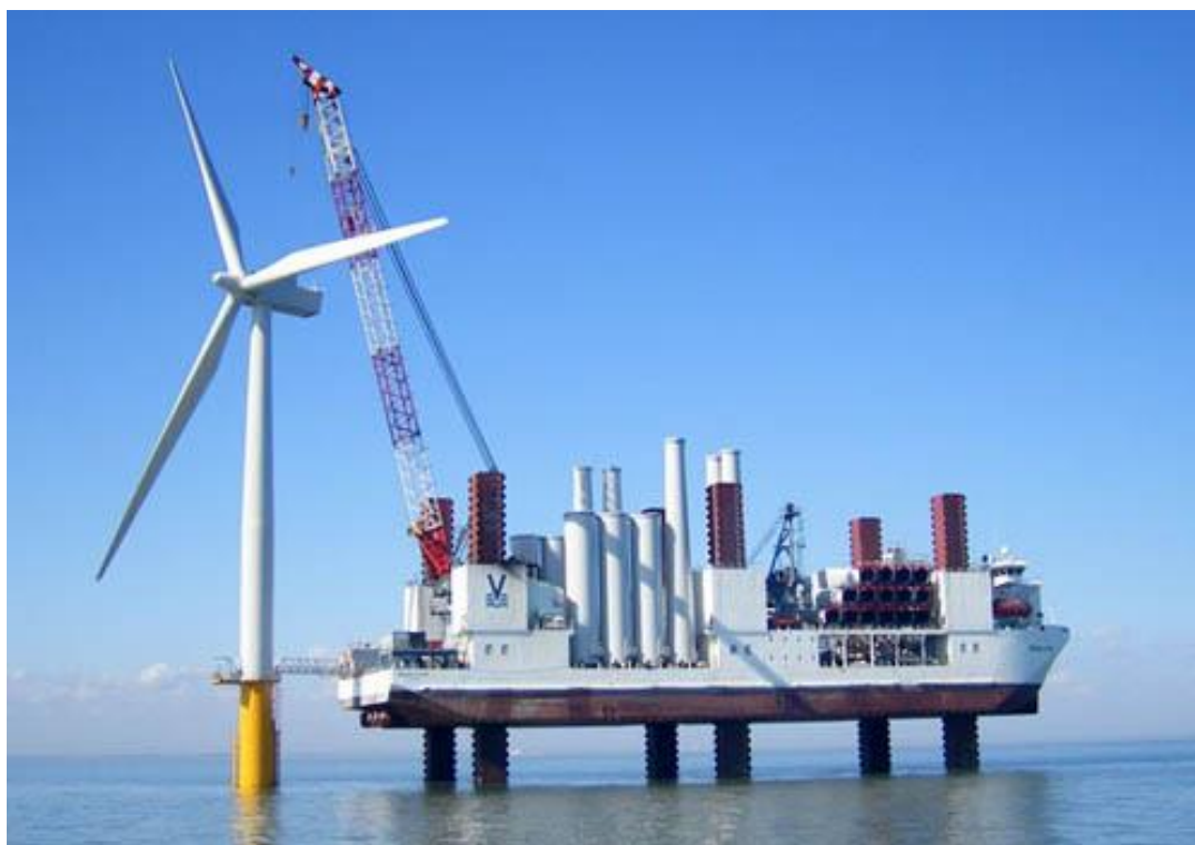
94-расм. Энг катта қувватли оффшор шамол электроқурилмаларини ўрнатиш.
