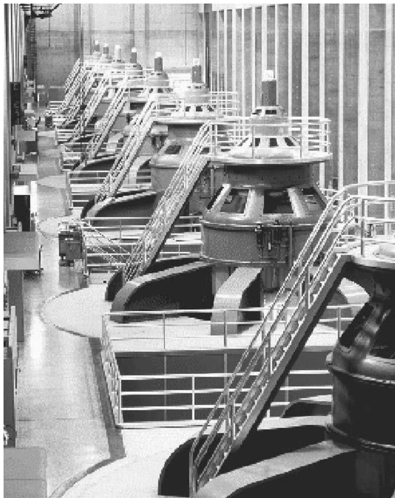
72-расм. ГЭСда гидротурбиналарининг жойлашиши.
