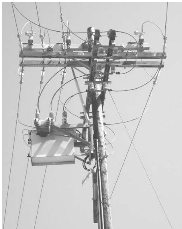
105-расм. Таксимловчи линиянинг автоматик қайта улагичи (автомат повторного включения линии распределения–АПВЛР)
