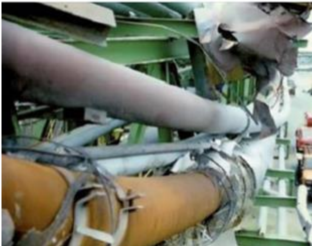
9-rasm. Gidravlik zarbalardan keyin quvurlarni mustahkamlash
