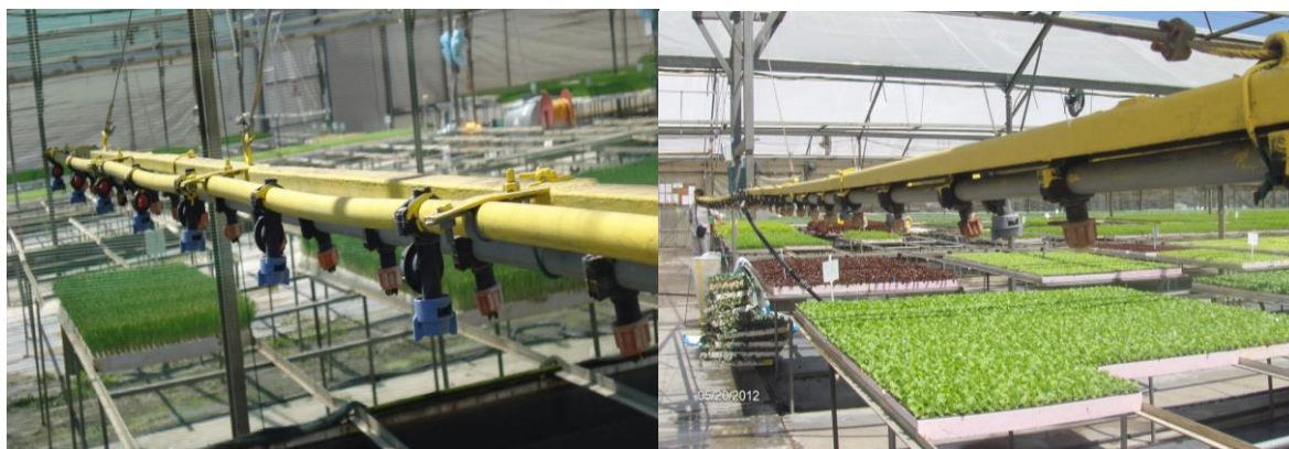
32- rasm. Ko'chatlarni yomg'irlatib sug'orish tizimi.
