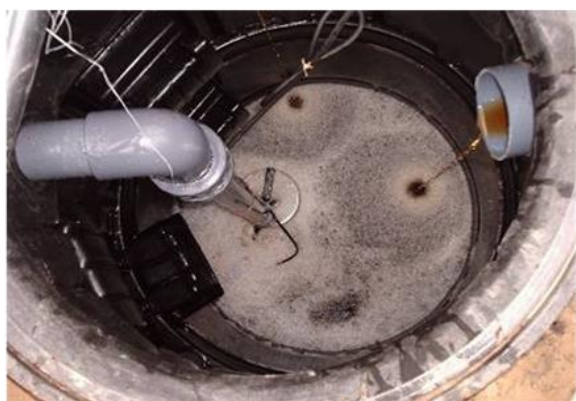
37- rasm. Suvni tuzlardan tozalovchi moslama.
