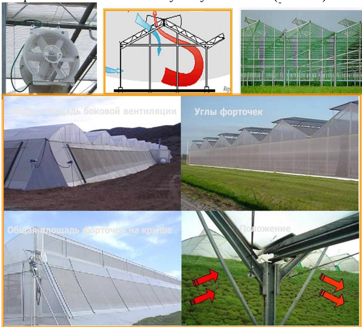
29- rasm. Issiqxonalarda shamollatish tizimi.
