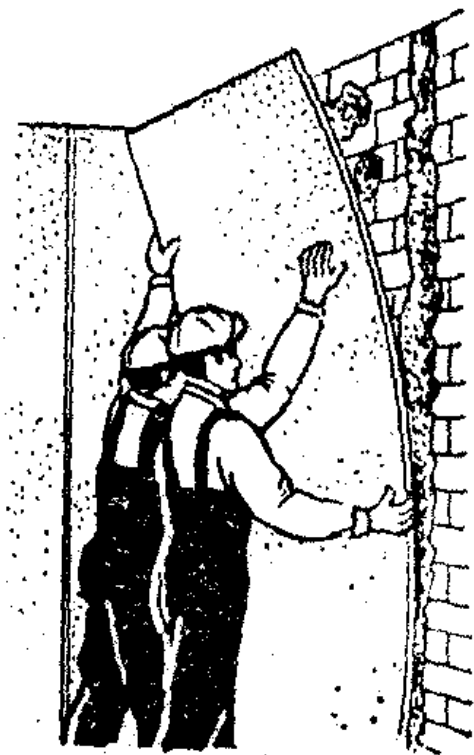
37-rasm. Devorlarni gips qoplama listlar bilan qoplash
