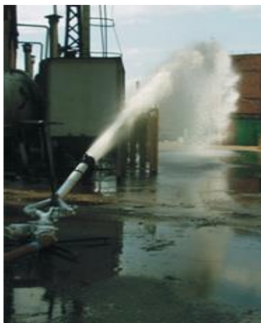
6.1.2-rasm. Suvli avtomatik yong'in o'chirish qurilmalari
