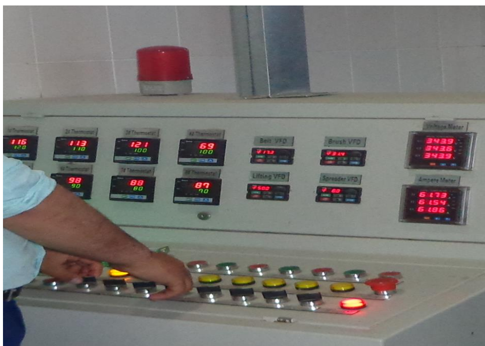
3.3.1-rasm. Quritish kamerasidagi havoning temperaturasini avtotermetrlar yordamida o'lchash.
