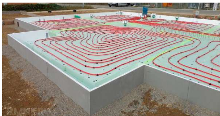
Рисунок 2. Утепленная шведская плита
