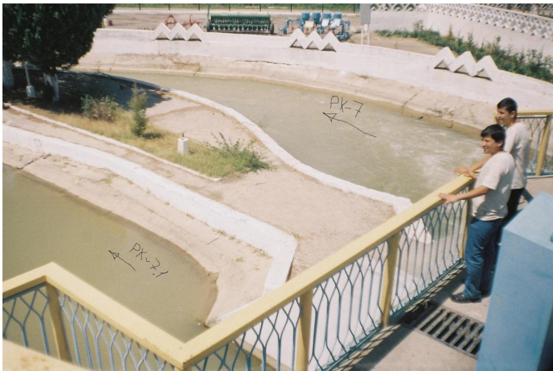
4-расм. Сувни тақсимлагич иншооти ва РК-7 канал боши.
