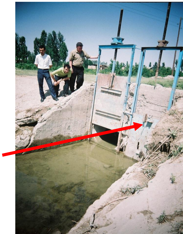
3- расм. Шурузак канали дарвозанинг ўнг шчити бузук.
