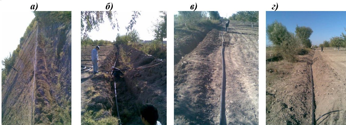
Расм 13. Магистрал пластмасса қувурларни хандақ қирғоғига ( а,в ) ва ичига ётқизиш ( б,г )
