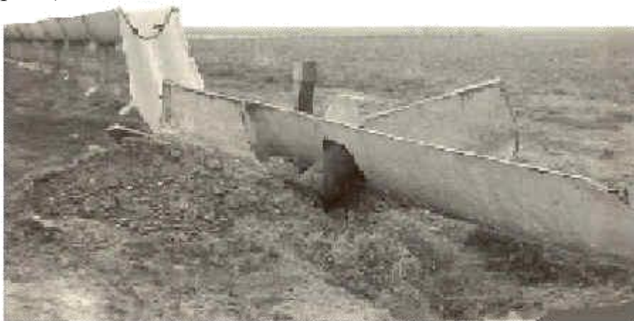
1-расм. Темир-бетон ариклар тизимининг суффозия натижасида бузилиши (Бухоро вилояти)
