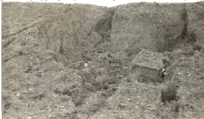
4-расм. Магистрал канал кутармасининг ювилиши (Бухоро вилояти)
