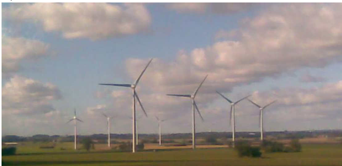
25-rasm. SHamol generator qurilmasi va elektrostansiyasi
