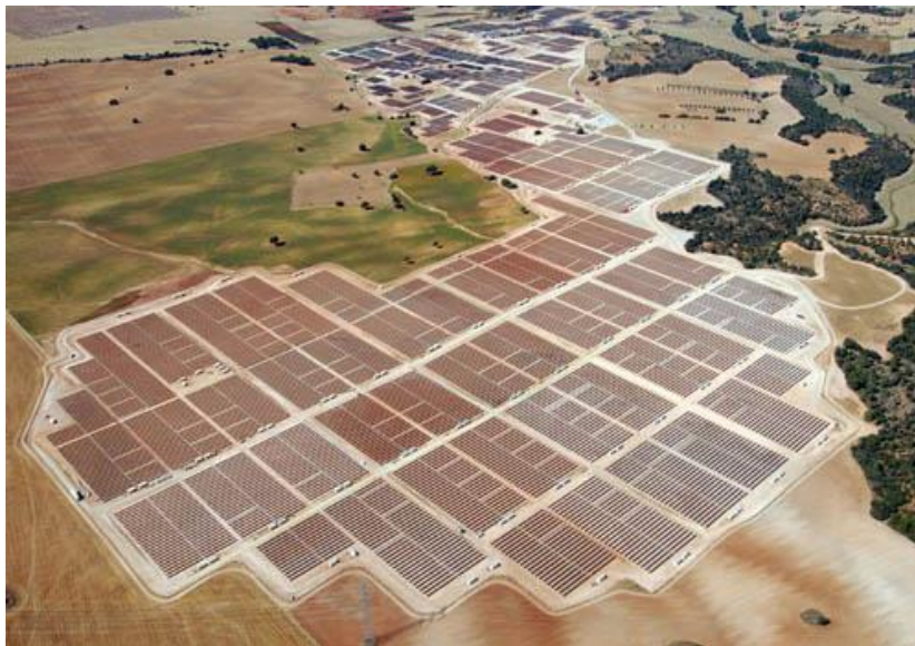
12-rasm.Dunyodagi eng katta fotoelektrik elektrostansiyasi.
