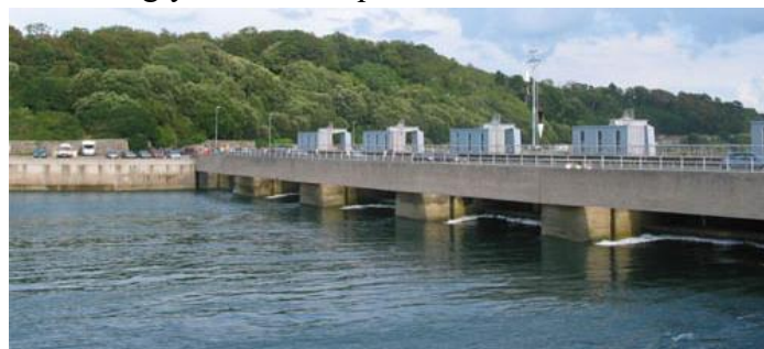
8-rasm. Suv sathning ko'tarilib-tushish prinsipi asosida ishlaydigan eng katta gidroelektrostansiya.
