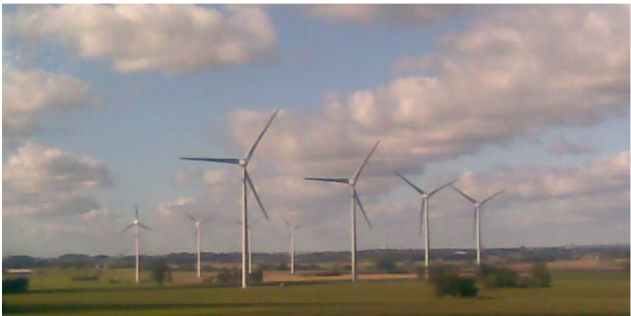
15-rasm. SHamol generator qurilmasi va elektrostansiyasi
