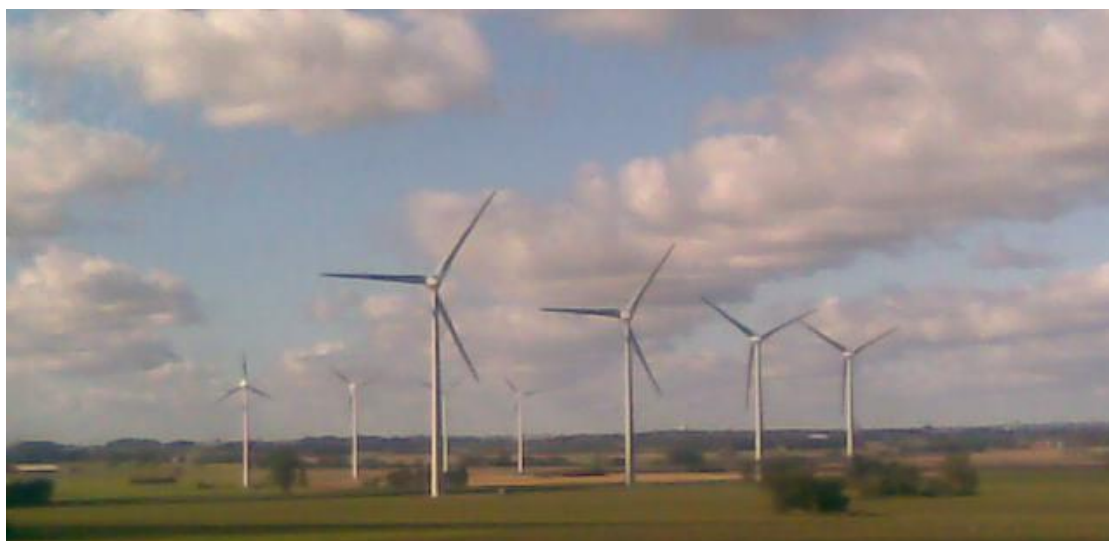
SHamol generator qurilmasi va elektrostansiyasi
