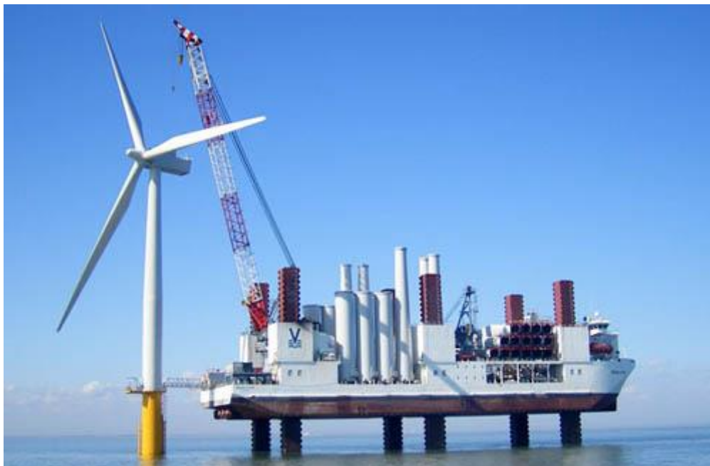
Eng katta quvvatli offshor shamol elektroqurilmalarini o‘rnatish.
