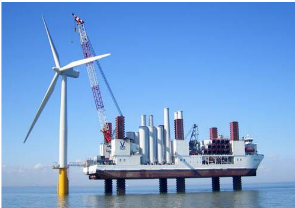
7 -rasm. Eng katta quvvatli offshor shamol elektroqurilmalarini o'rnatish.
