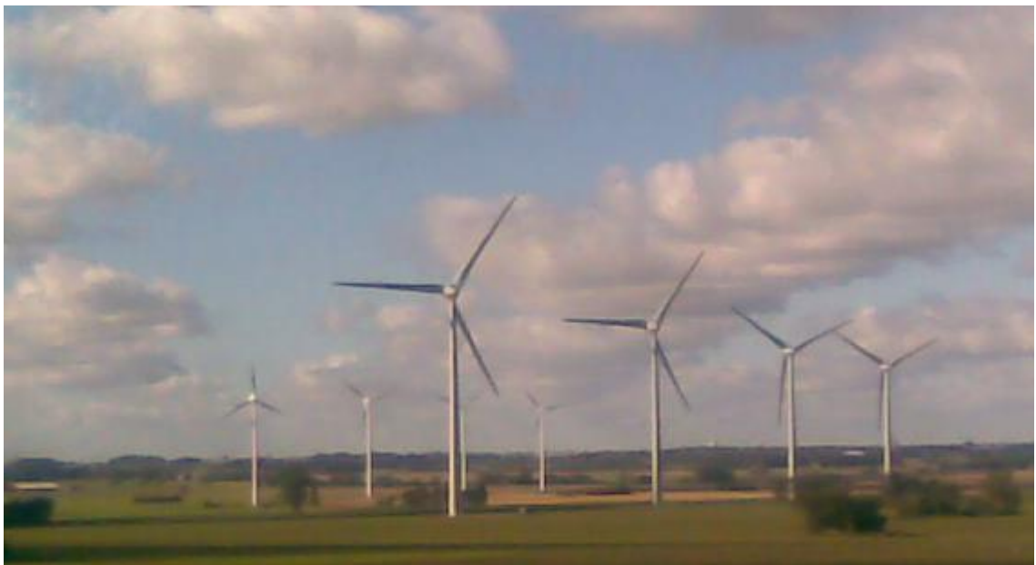
SHamol generator qurilmasi va elektrostansiyasi
