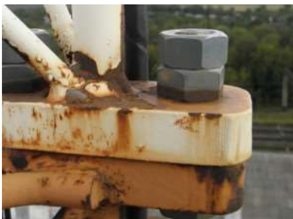
1-Rasm. Metall konstruksiyalarni tashqi muhit ta'sirida zanglanishi va tozalash jarayoni
