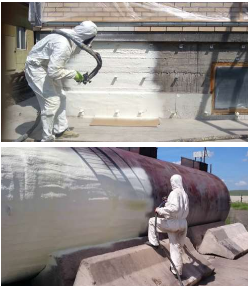
8.10-rasm. Poliuretan ko'pikli kompozitsiyaning purkash usuli.
