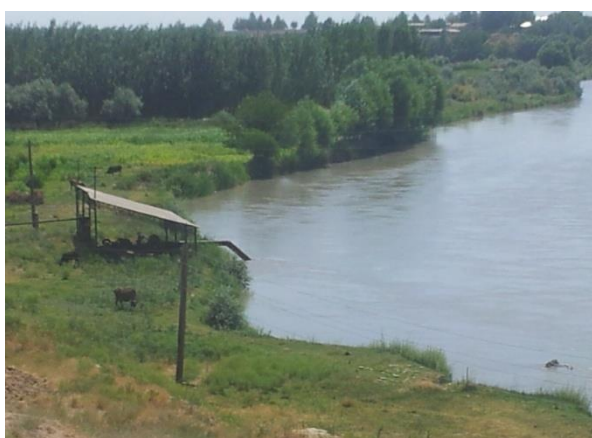
11-расм. I-кўтарув насос станцияси
