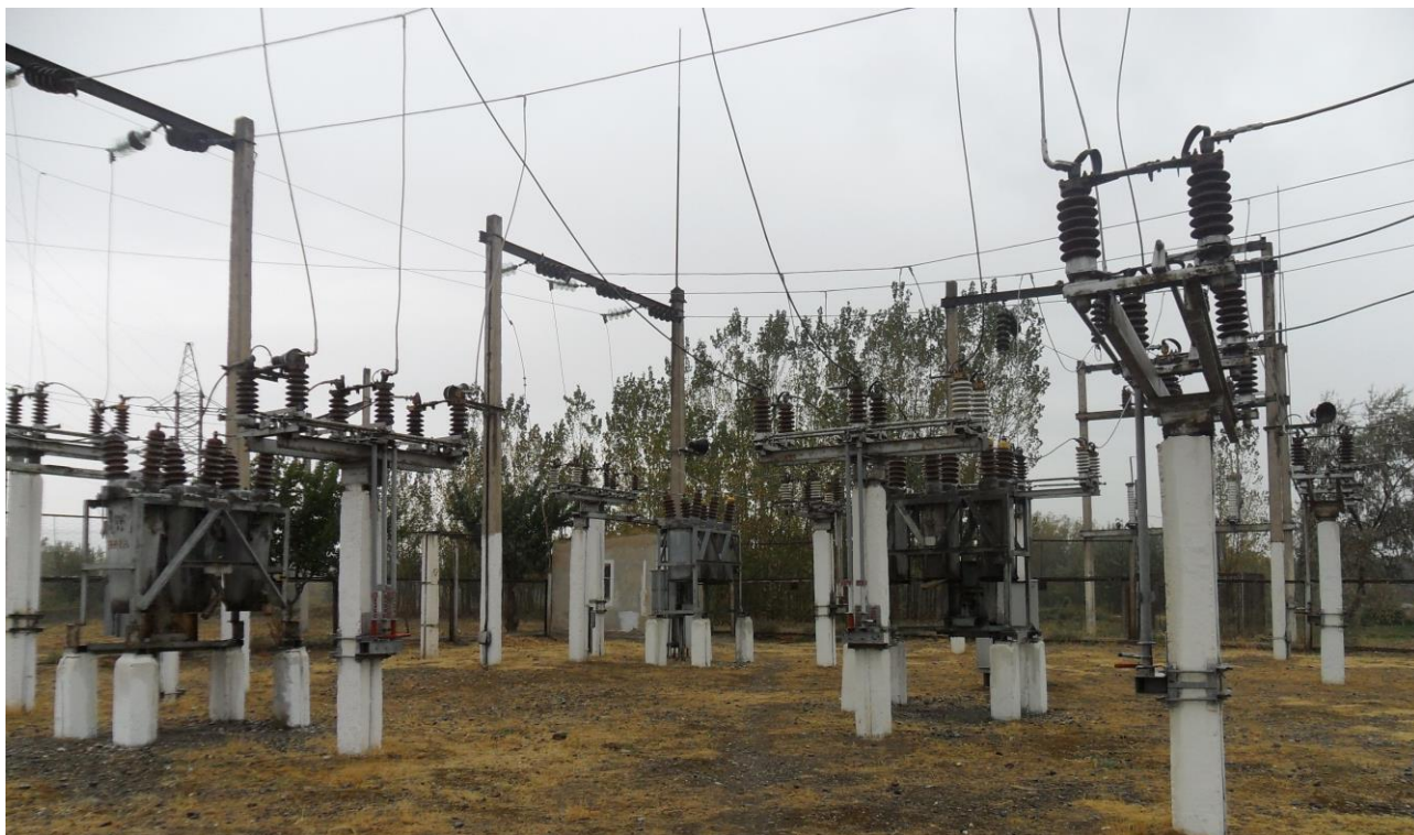
2.2-расм . 35 кВ кучланишли ажратгичнинг кўриниши.
