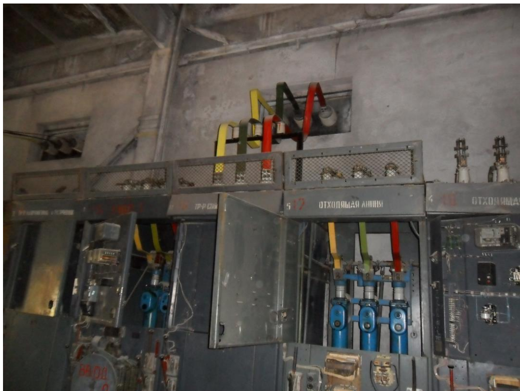
2.3 - расм. КСО 272 шкафида мой ўчиргичнинг жойлашуви.
