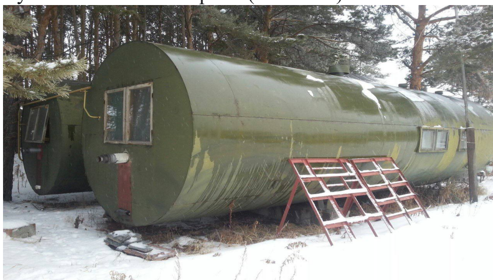
2.9. –rasm. Butun metall birlashtirilgan blok namunasi (Rossiya)
