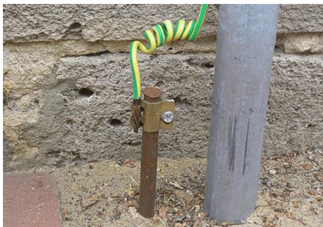
13-rasm: Erlantirish qurilmasining erga ulanish qismining ko'rinishi.
