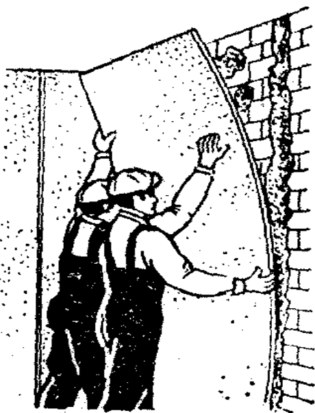
37-rasm. Devorlarni gips qoplama listlar bilan qoplash
