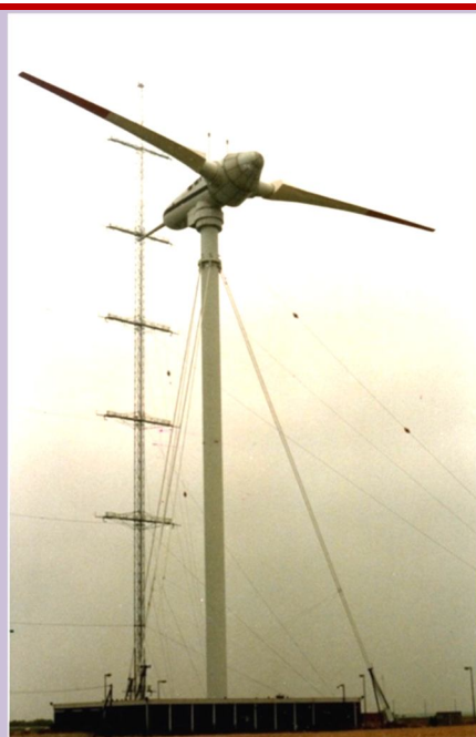
1.3.8-шакл. Гровиан-1 ШЭС- нинг умумий кўриниши D=100 м, N=3 МВт, Германия
