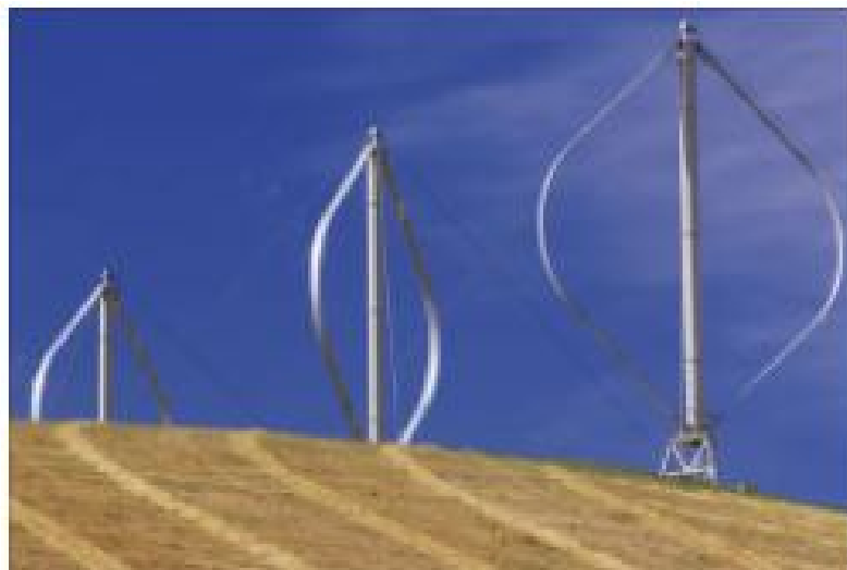
1.7.3 – Даръе ротори асосида лойиҳаланган шамол электр станцияси
