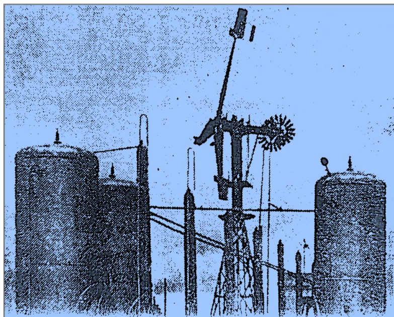
1.3.10-шакл. 100 кВт лик сувни кислород ва водородга синтез қилиш агрегати
