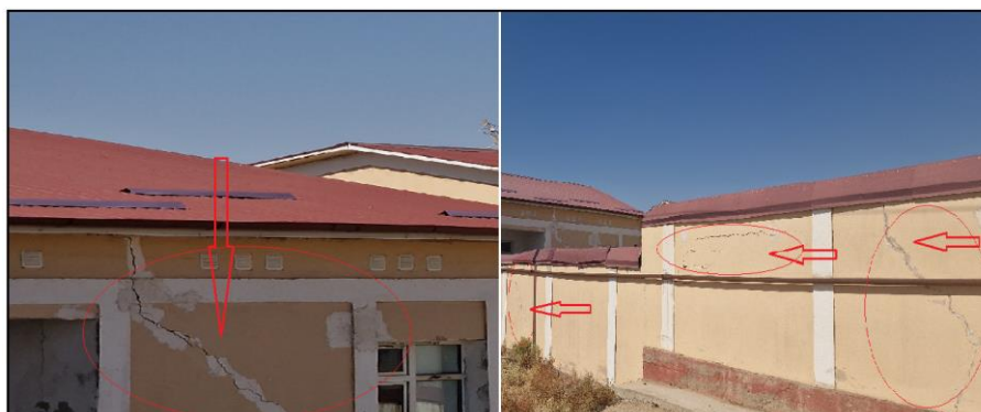
1-расм. Зарафшон шаҳрининг чеккасида қурилган бинолар ва тўсувчи деворларда дарзликларнинг ҳосил бўлиши
