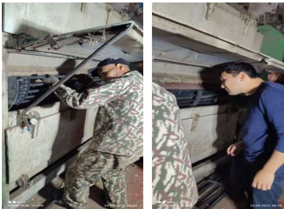
Рисунок 8. Фотографии процесса установки усовершенствованных колосниковых решеток
