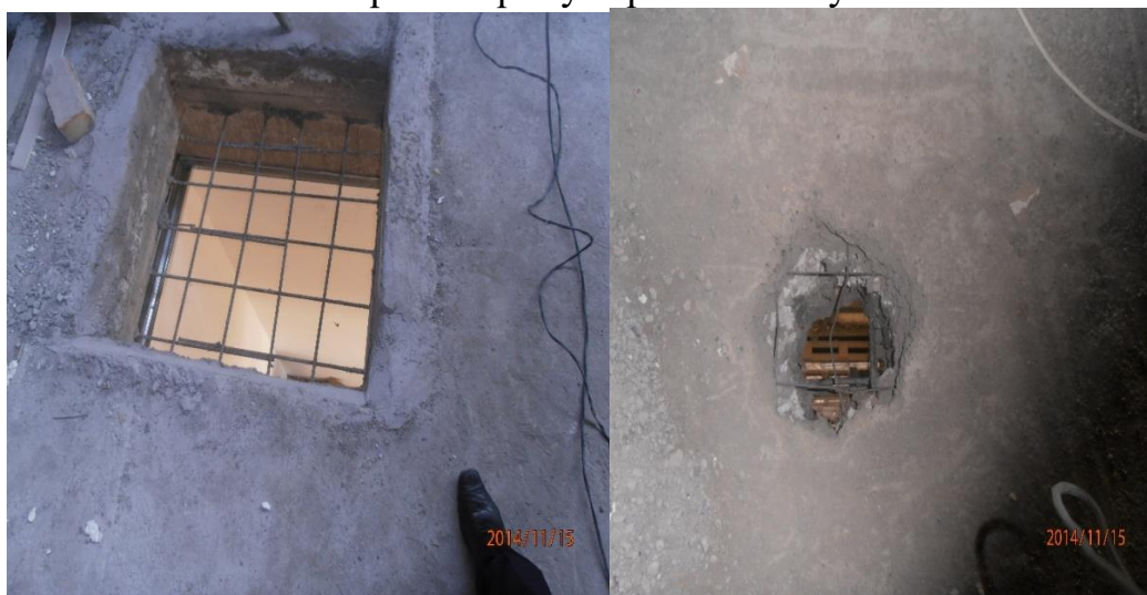
11.1- rasm. Keramzit betondan qilingan issiqlik izolyatsiyasi qo'lamasi
