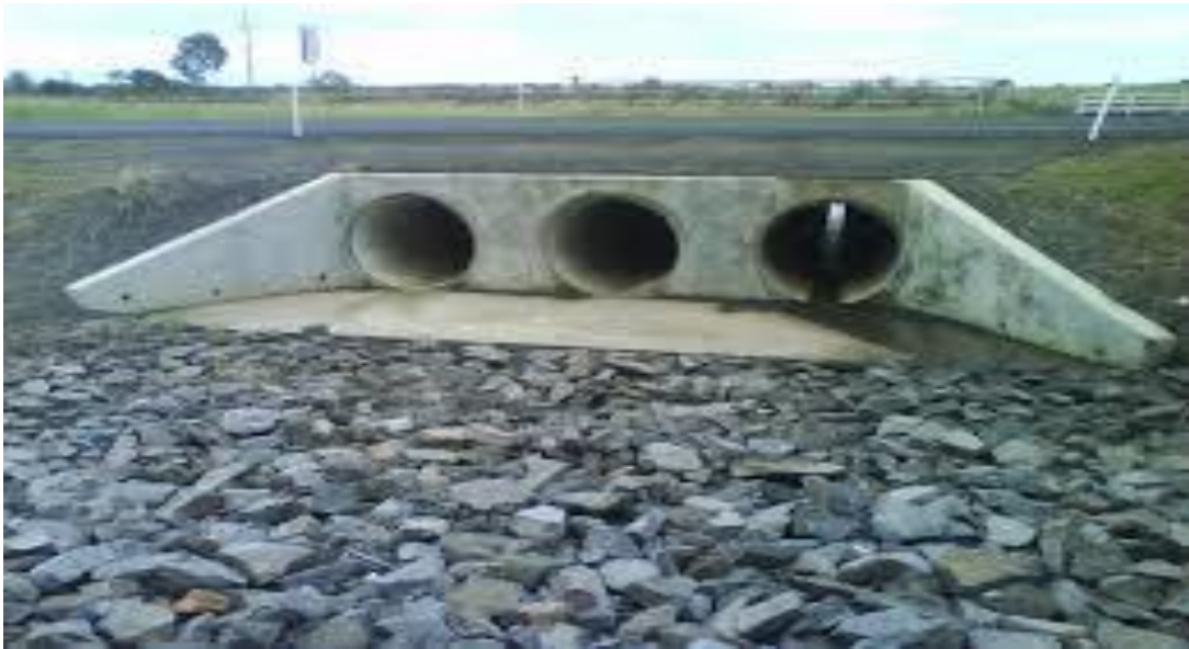
32-rasm. Avtomobil yo‘lidagi suv o‘tkazuvchi quvur
