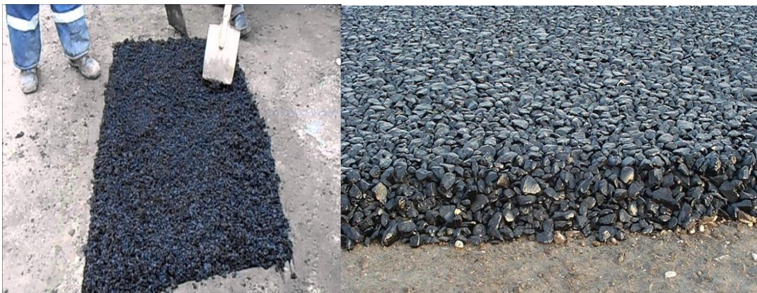
13.1-rasm Sovuq asfaltobetona
